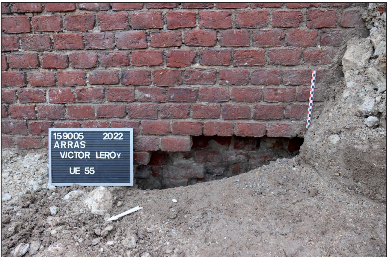
Fig. 29 : Arras, rue Victor Leroy, détail du parement de la maçonnerie 56, cliché O. Dewitte - DA, CD 62.
