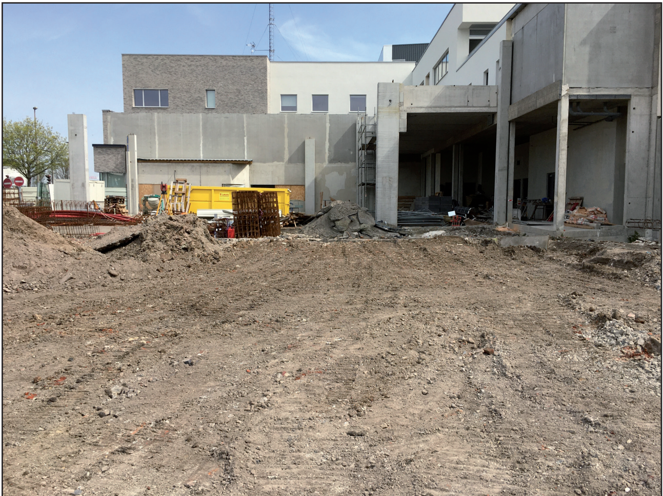
Fig. 5 : Arras, rue Victor Leroy, chantier de reconstruction du SDIS et zone d'intervention archéologique (phase 4), cliché DA, CD 62.
