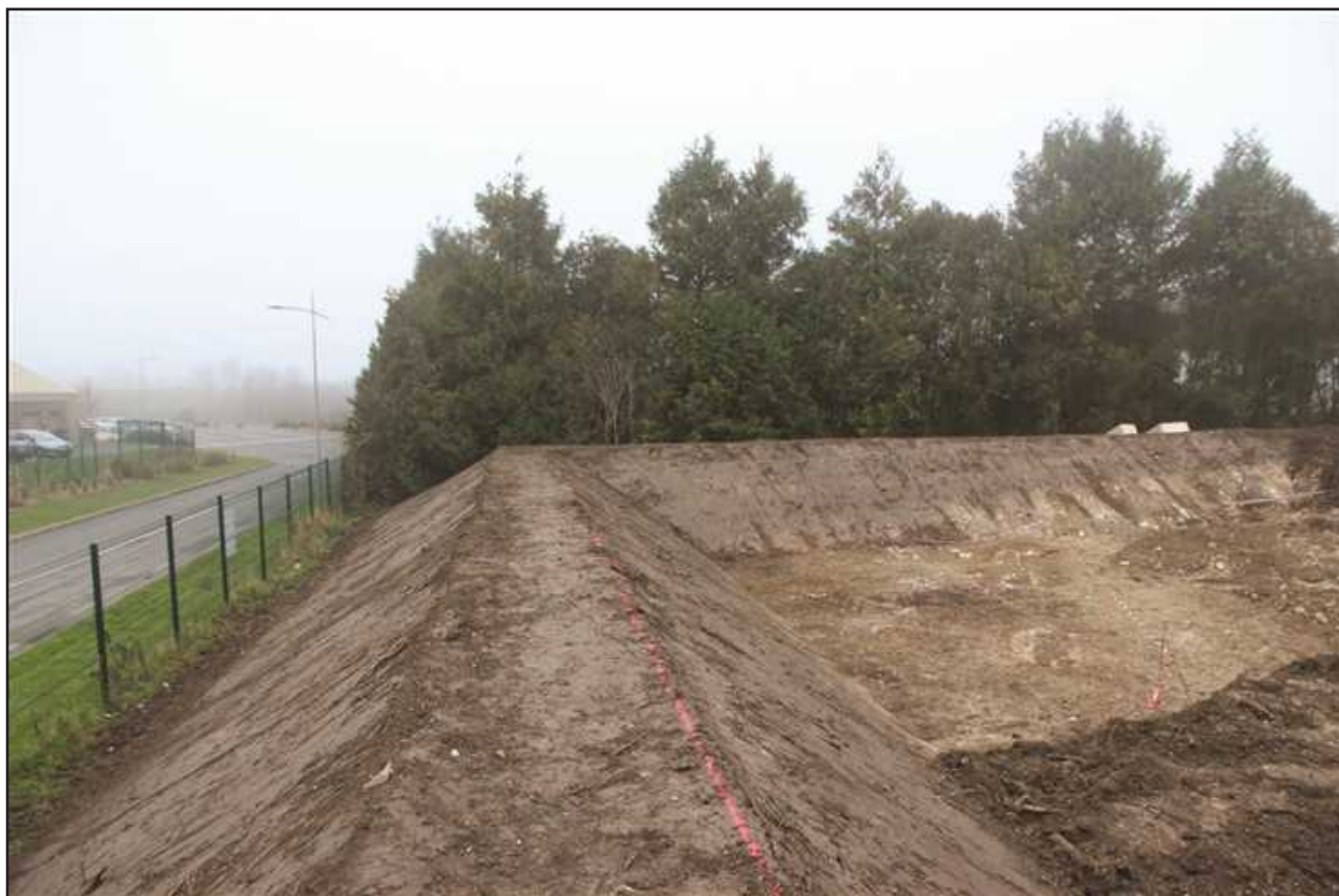
Fig. 6 : Bapaume, 68 rue de la République, vue générale du talus, V. Merkenbreack - DA 62.
