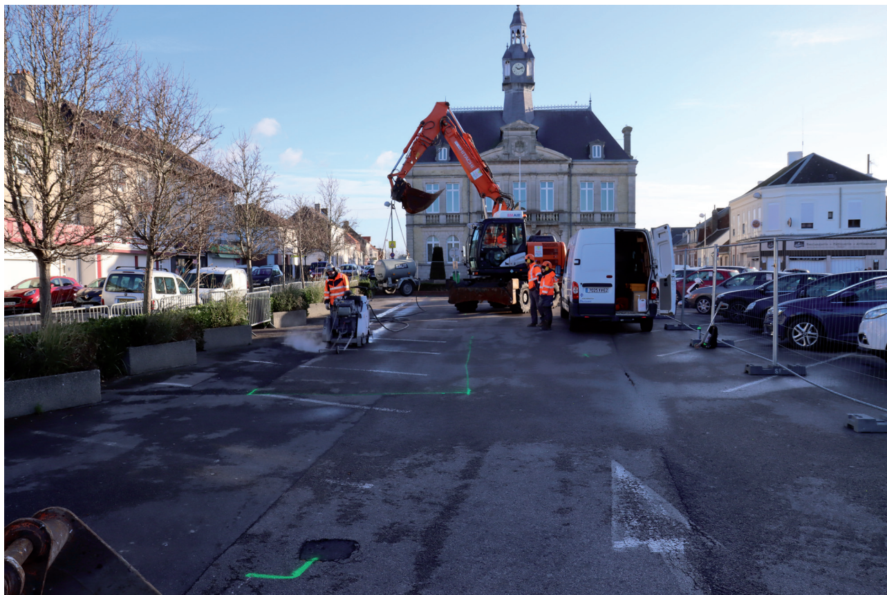
Fig. 9 : vue du sciage en cour de la tranchée 10, N. Majchrzak - DA, CD 62.
