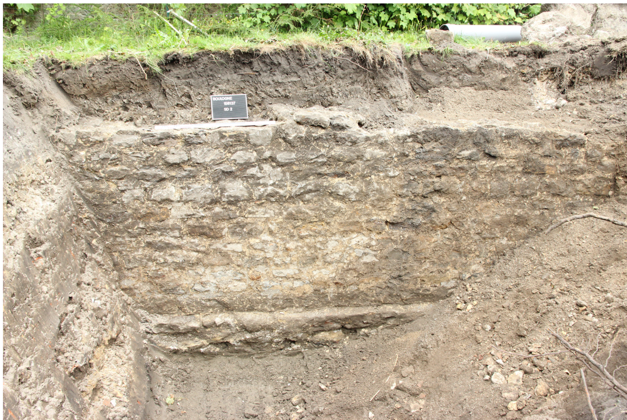
Fig. 11 : Boulogne-sur-Mer, 22 Bd du Prince Albert, Vue du mur de terrasse dans le sondage 2, V. Merkenbreack - DA CD62.
