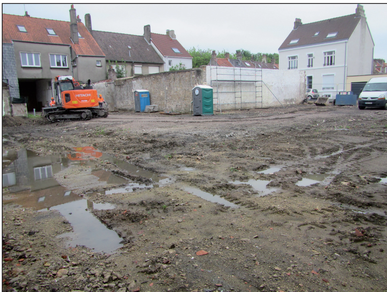
Fig. 16 : Boulogne-sur-Mer, rue Framery, environnement du diagnostic, cliché Y. Rabahi - DA, CD 62.
