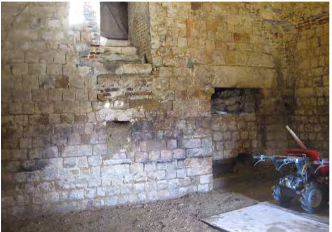
Fig. 7 : Bours, le Donjon, le cellier après le curage des remblais du XVI e siècle. A droite, l'accès primitif de la cave avec la pierre de linteau massive, reposant sur les coussinets des piédroits. Le linteau est soulagé par une plate-bande de trois claveaux (cliché Christelle Denis, Communauté de Communes du Pernois).
