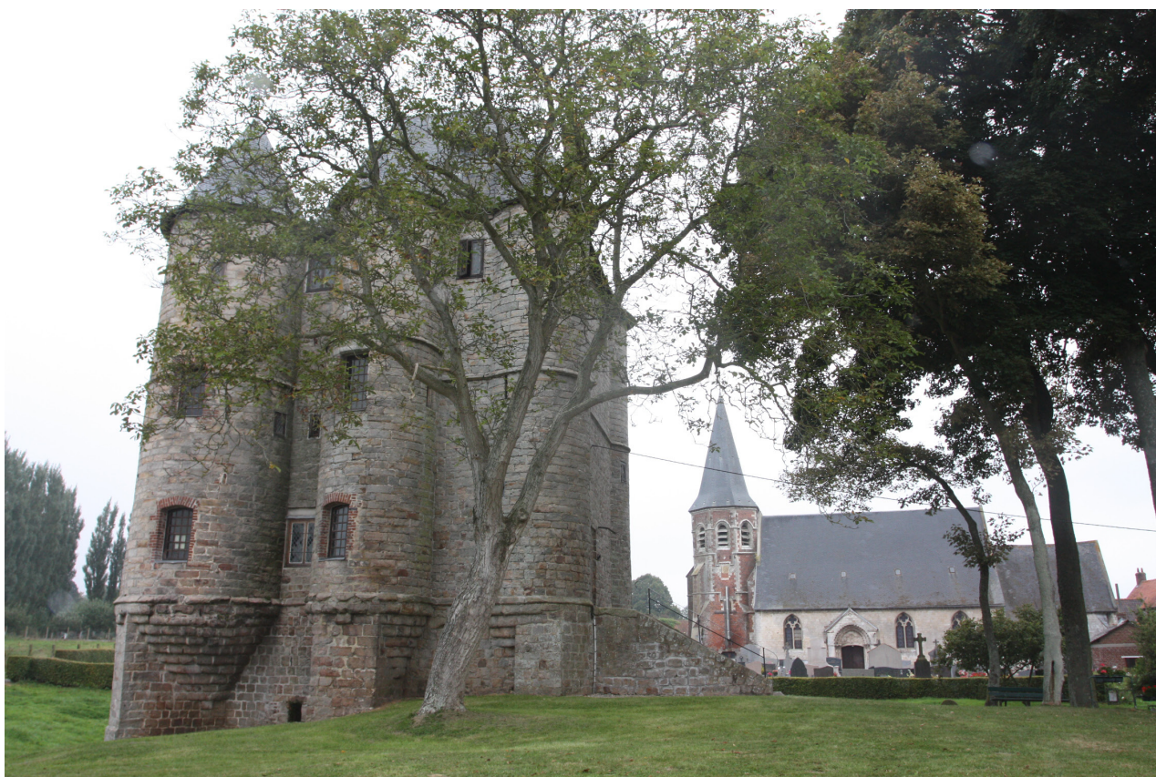
Fig. 15 : Bours, le Donjon, vue vers le nord du donjon, de la plateforme au premier-plan, des douves à gauche et de l'église paroissiale en arrière-plan - V. Merkenbreack - DA 62.
