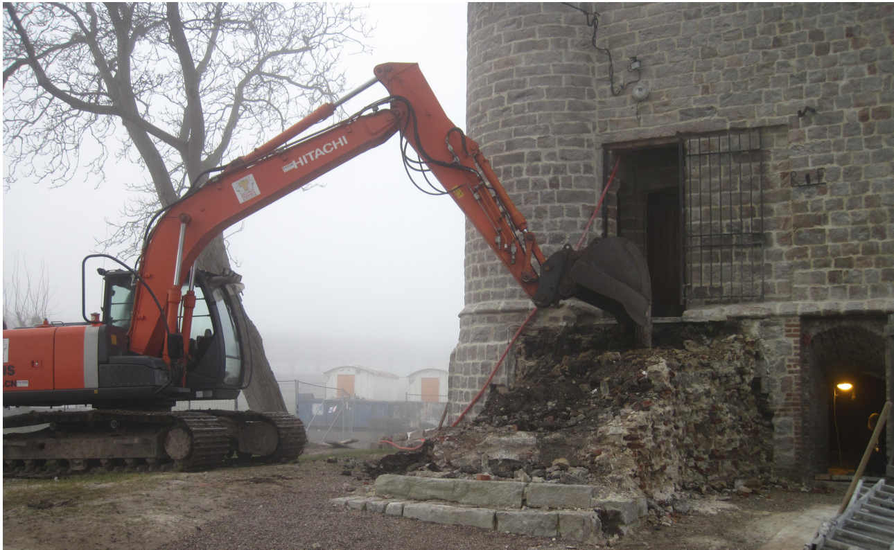
Fig. 8 : Bours, le Donjon, démontage de l'escalier contemporain en 2015, J.-M. Willot - DA 62.
