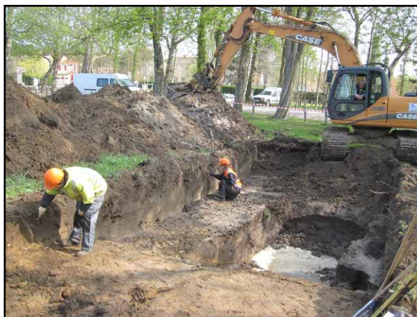
Condette, Château d'Hardelot : Sondage en cours dans le fossé.
