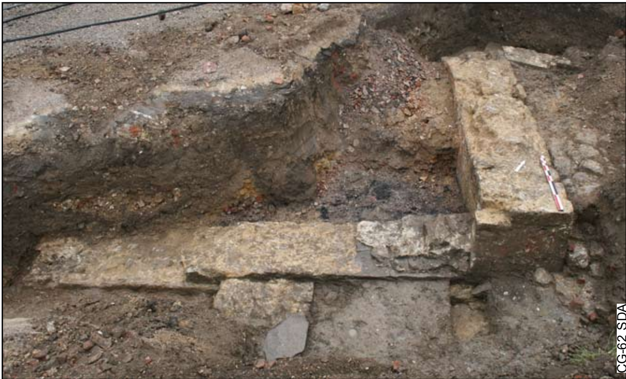
Fig. 15 : Condette, Château d'Hardelot : vue vers le nord-est du bâtiment US 28.
