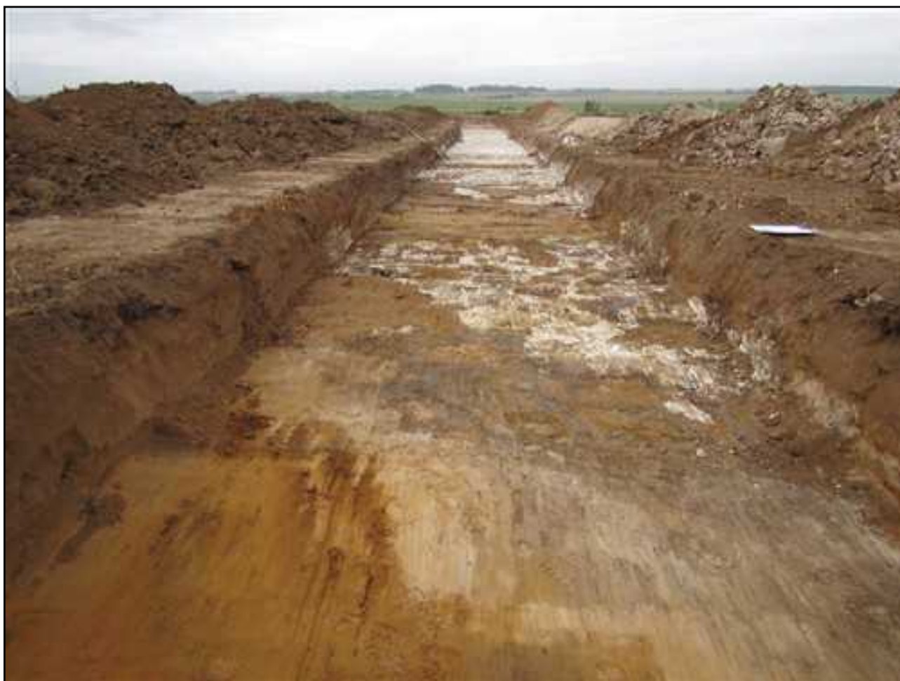
Fig. 43 : RD 60, phase 2, Zone 3, vue générale de la tranchée 9000 vers le nord-ouest, cliché C. Lautridou - DA 62.
