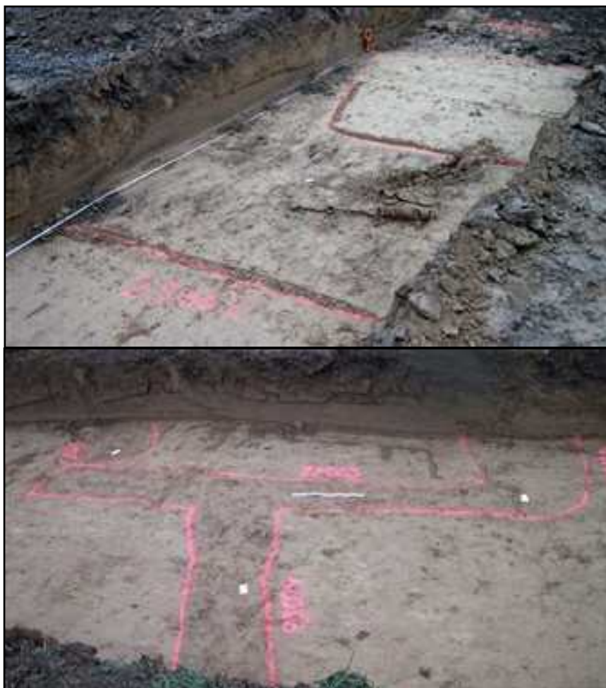
Fig. 84 : RD 60, phase 2, Zone 8, vues générales d'une tranchée avec un piquet en fer torsadé et du système fossoyé de la Première Guerre mondiale, cliché I. Louiso, DA 62.
