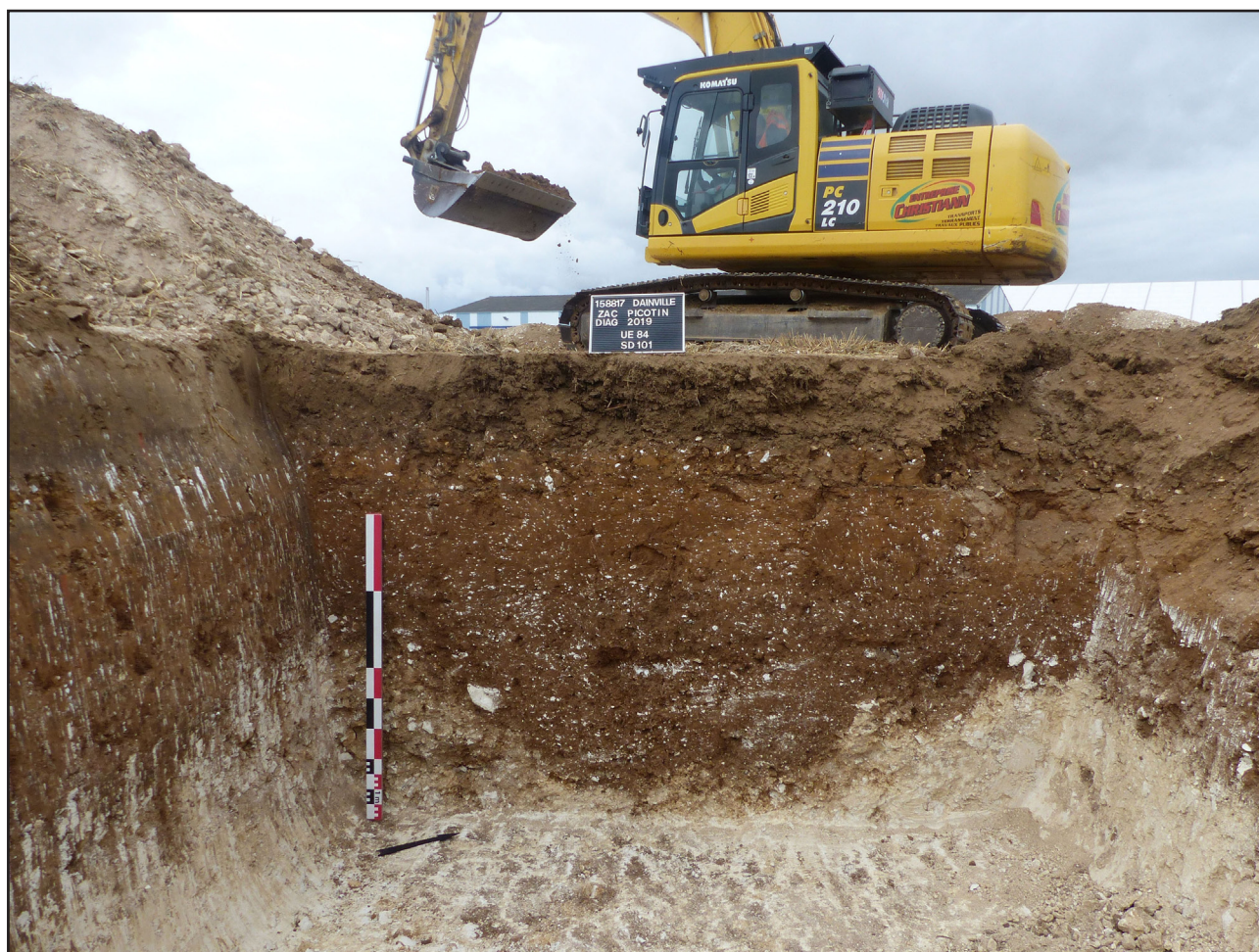
Fig. 25 : Dainville, ZAC Dainville-Achicourt-le Picotin, vue de la coupe du fossé 84 - cliché : DA, D 62.
