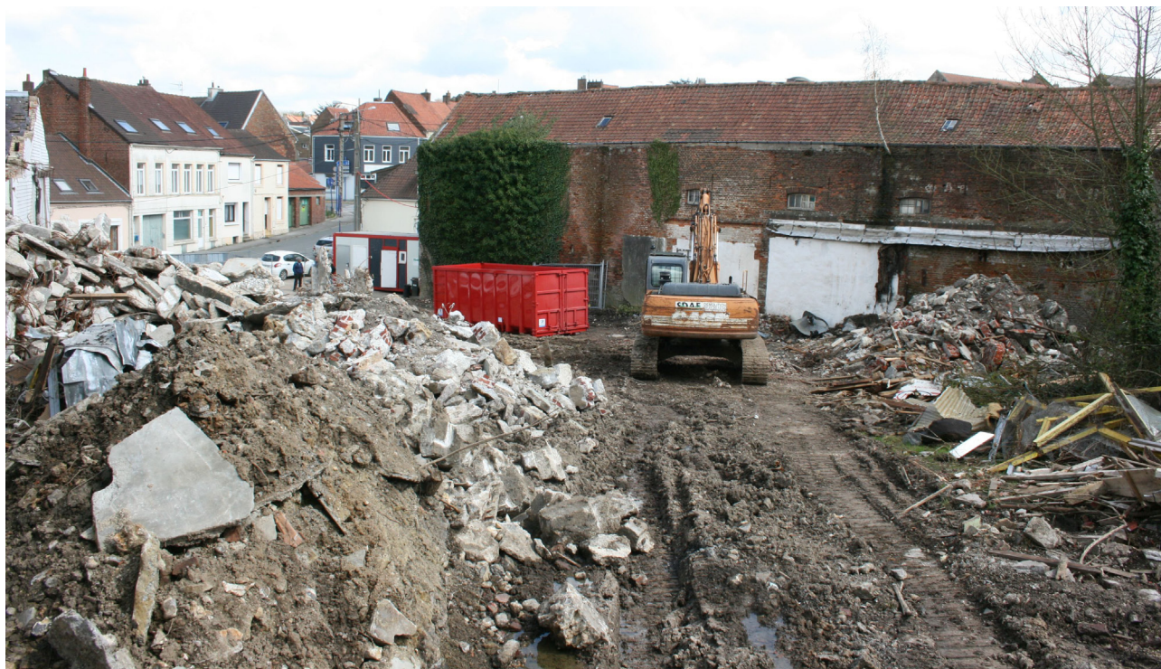
Fig. 11 : Desvres, rue Salengro, les édifices en cours de démolition, la rue Salengro est à gauche en arrière-plan, cliché Chr. Costeux - DA CD 62.
