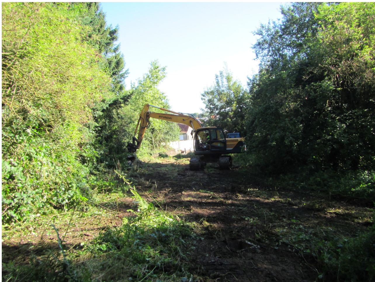
Fig. 12 : Desvres, rue Salengro, le couvert arboré à l'arrière des parcelles. La pelle a tracé un passage dans une partie du massif non concerné par une mesure de protection, cliché J.-M. Willot- DA CD 62.
