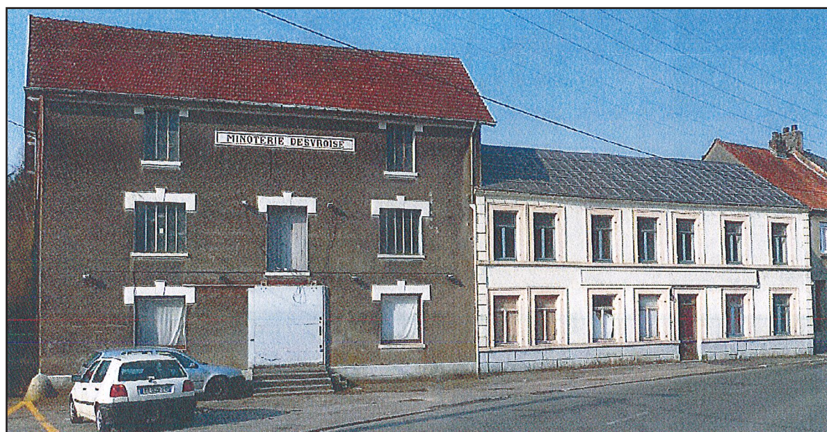
Fig. 6 : Desvres, rue Salengro, les édifices de la minoterie avant leur destruction, cliché Mairie de Desvres .
