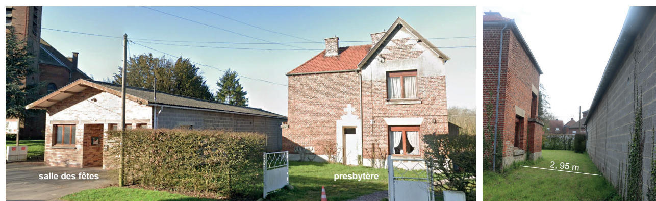
Fig. 10 : Dury, rue de la Mairie, la salle des fêtes et le presbytère, vus depuis la rue de la Mairie ( google street view, mars 2021 ) ; étroitesse du passage entre le presbytère et la salle des fêtes, vue du fond de la parcelle , cliché H. Agostini - DA, CD 62 .
