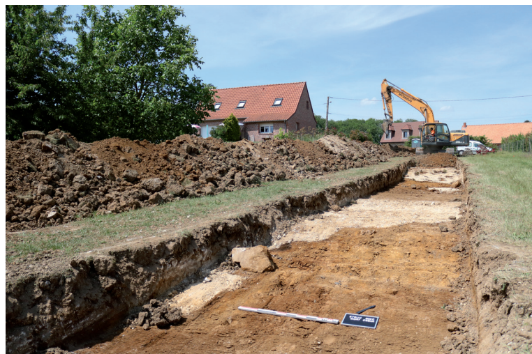
Fig. 6 : vue du substrat naturel au sein de la tranchée de diagnostic, V. Merkenbreack - DA 62.
