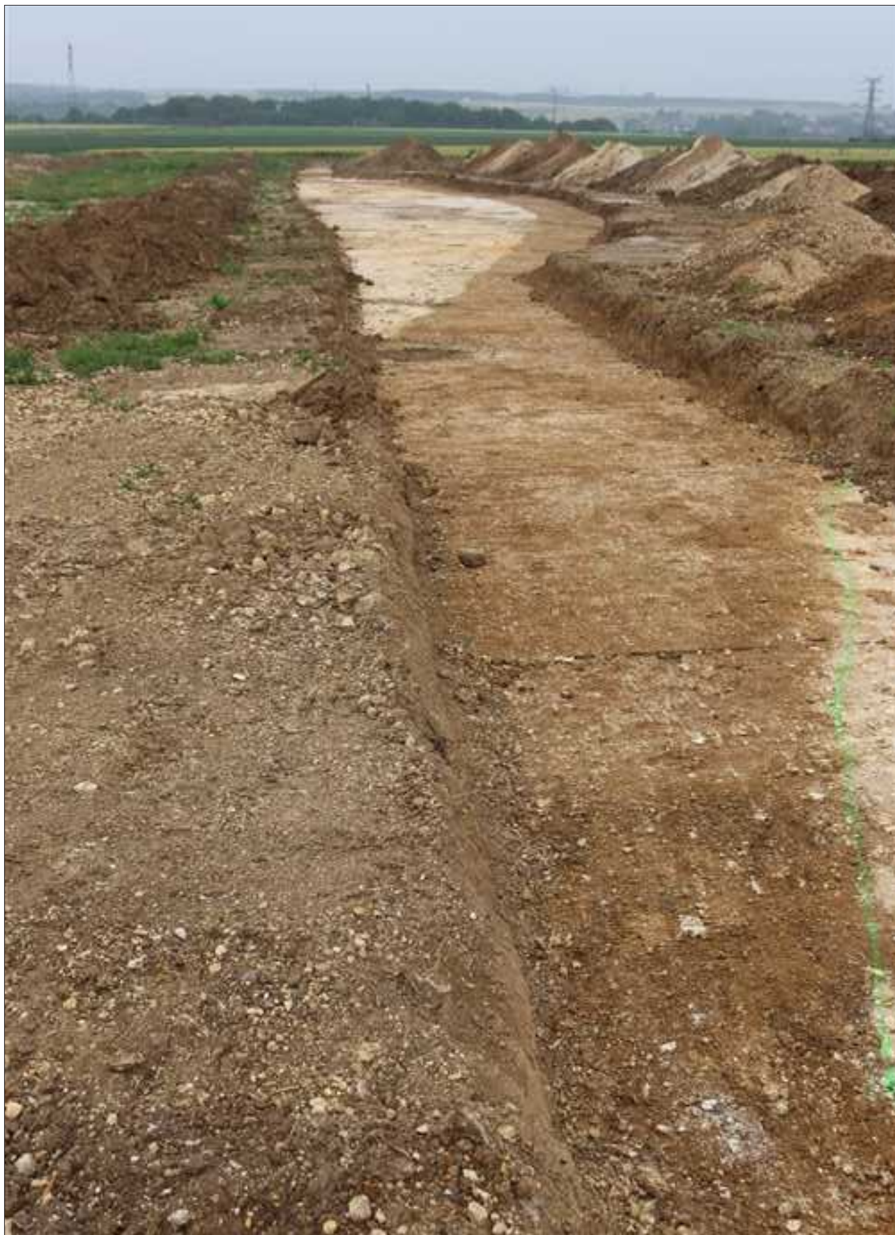
Fig. 125 : Feuchy, Saint-Laurent-Blangy, Tilloy-lès-Mofflaines, Extension de la ZI Est, élargissement de la tranchée 6500 suivant le tracé du fossé 6501, vers le nord, cliché A. Carneaux - DA, CD 62.
