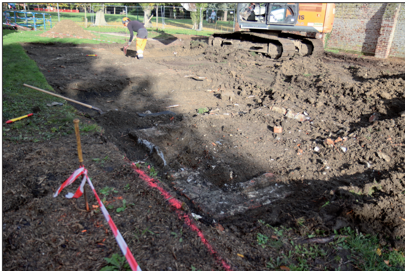
Fig. 12 : Fleurbaix, Place Jean Le Vasseur, Décapage de la zone à l'arrière de l'église, crédit O. Dewitte - DA, CD 62..
