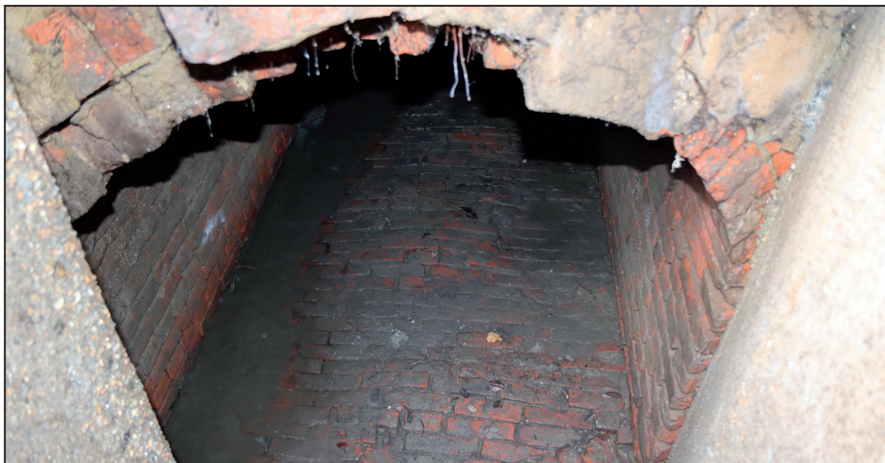
Fig. 11 : Fleurbaix, Place Jean Le Vasseur, Vue intérieure de la voûte, crédit O. Dewitte - DA, CD 62.
