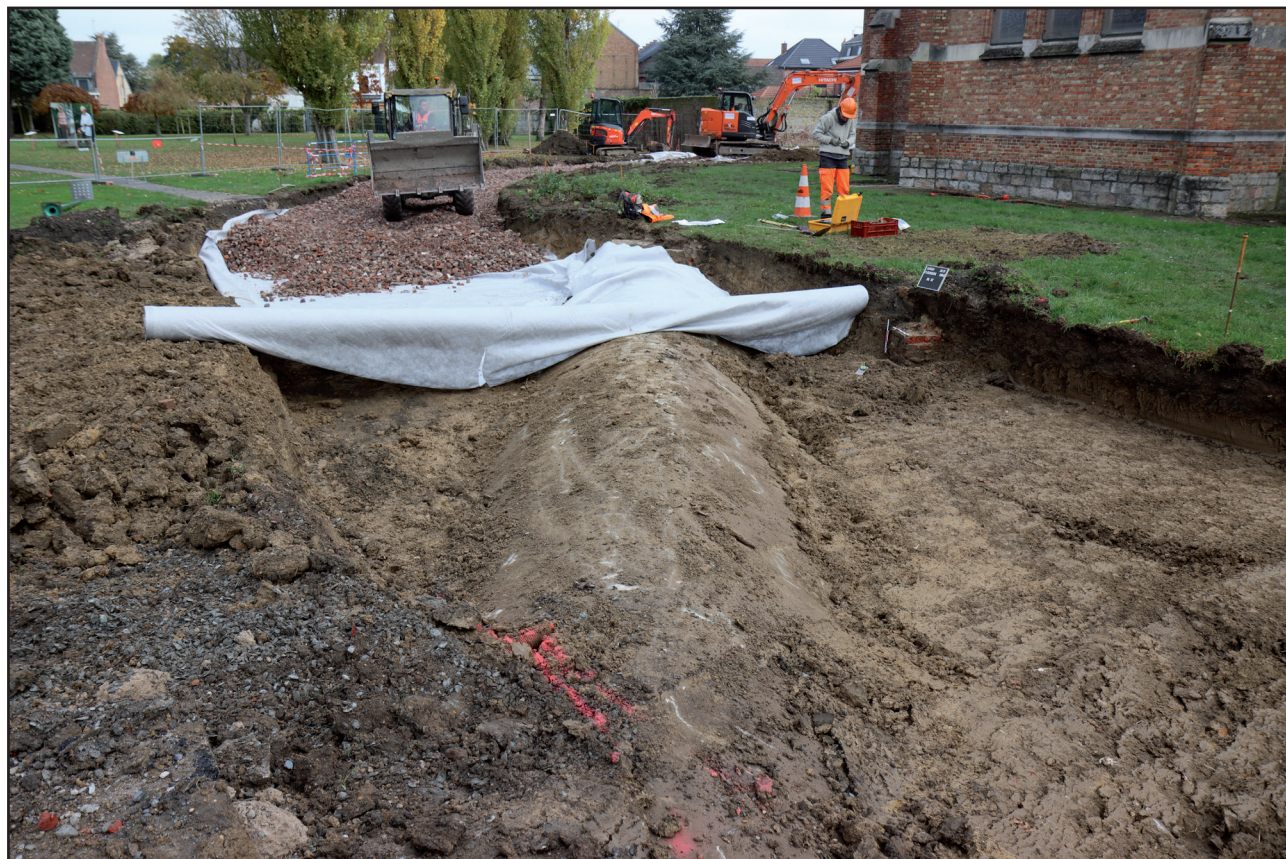
Fig. 39 : Fleurbaix, Place Jean Le Vasseur, Photo de la voûte , crédit O. Dewitte - DA, CD 62.
