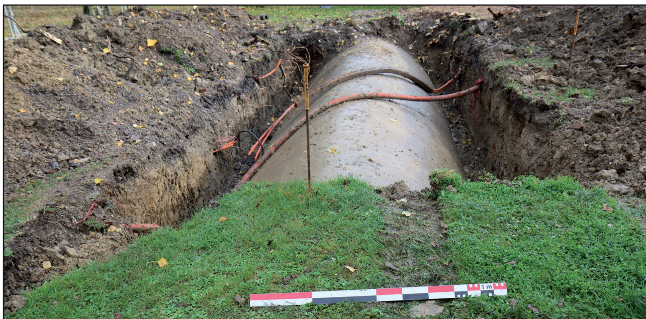
Fig. 10 : Fleurbaix, Place Jean Le Vasseur, Vue extérieure de la voûte, crédit O. Dewitte - DA, CD 62.
