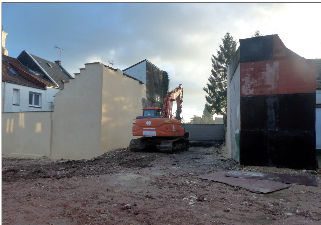
Fig. 10 : Fruges, Centre-Bourg, vue générale du site, cliché : G. Guidi-Rontani - DA 62
