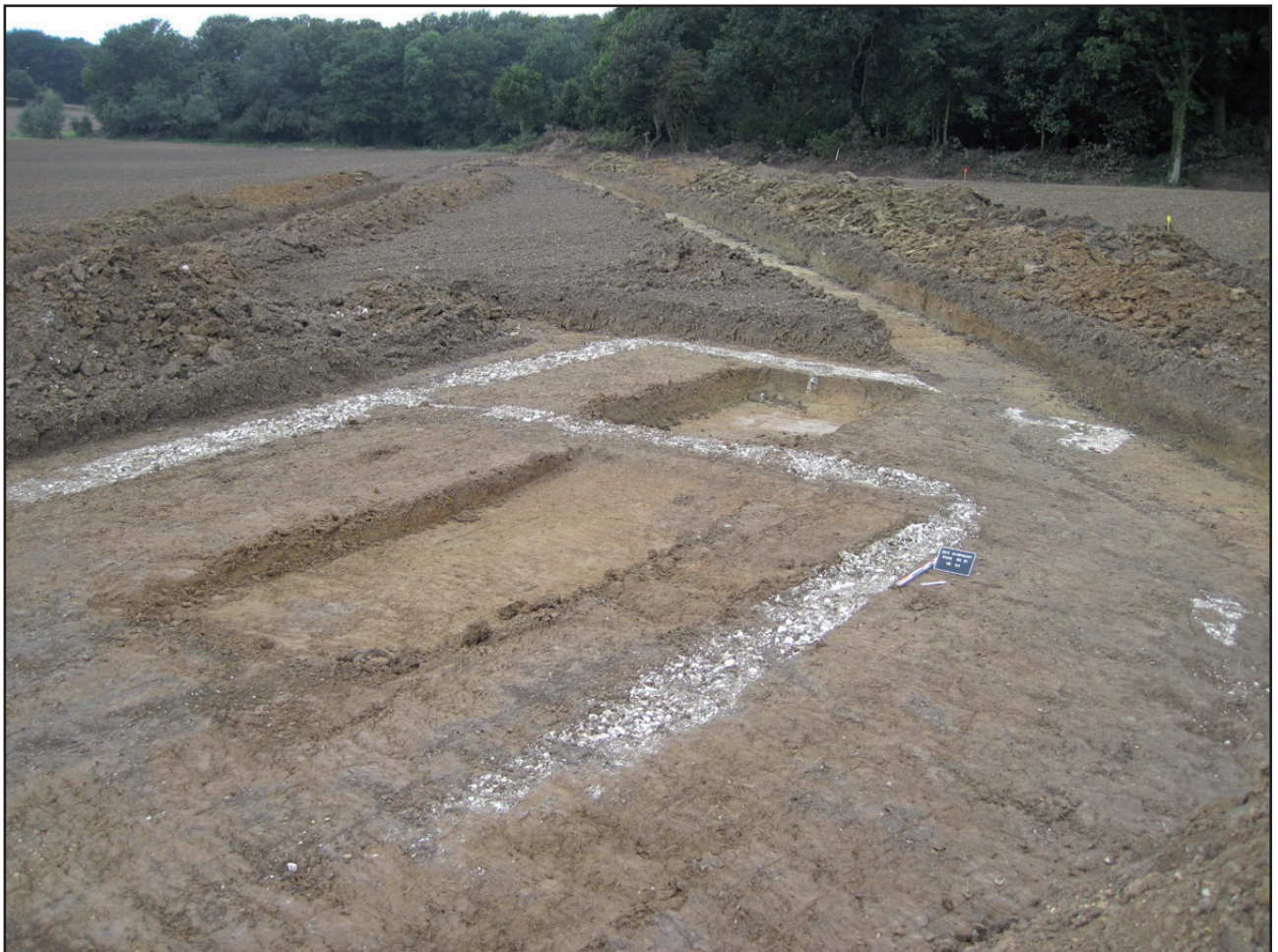
Fig. 7 : Givenchy, vue des fondations du bâtiment 4
