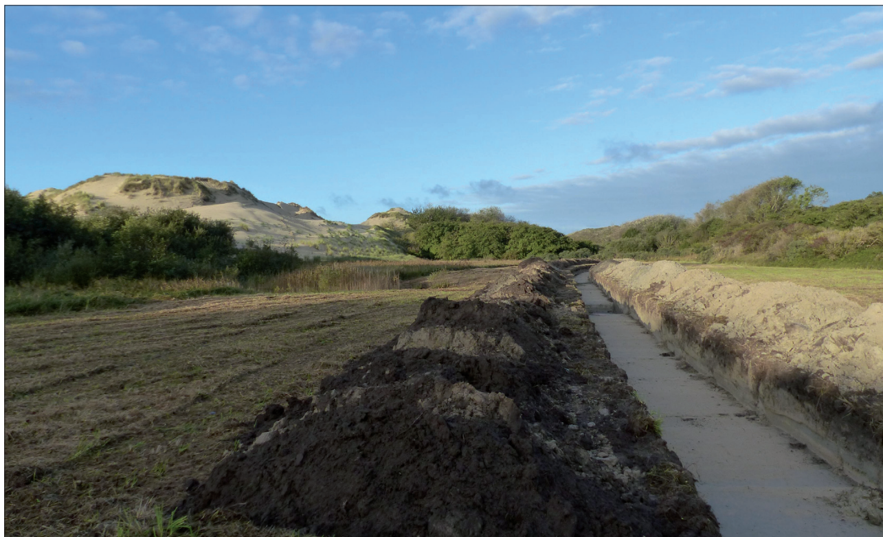
Fig. 42 : Groffliers, digue rétro littorale, Secteur Bois des Sapins, vue générale vers l'ouest de la tranchée 400, cliché O. Dewitte - DA, CD 62.
