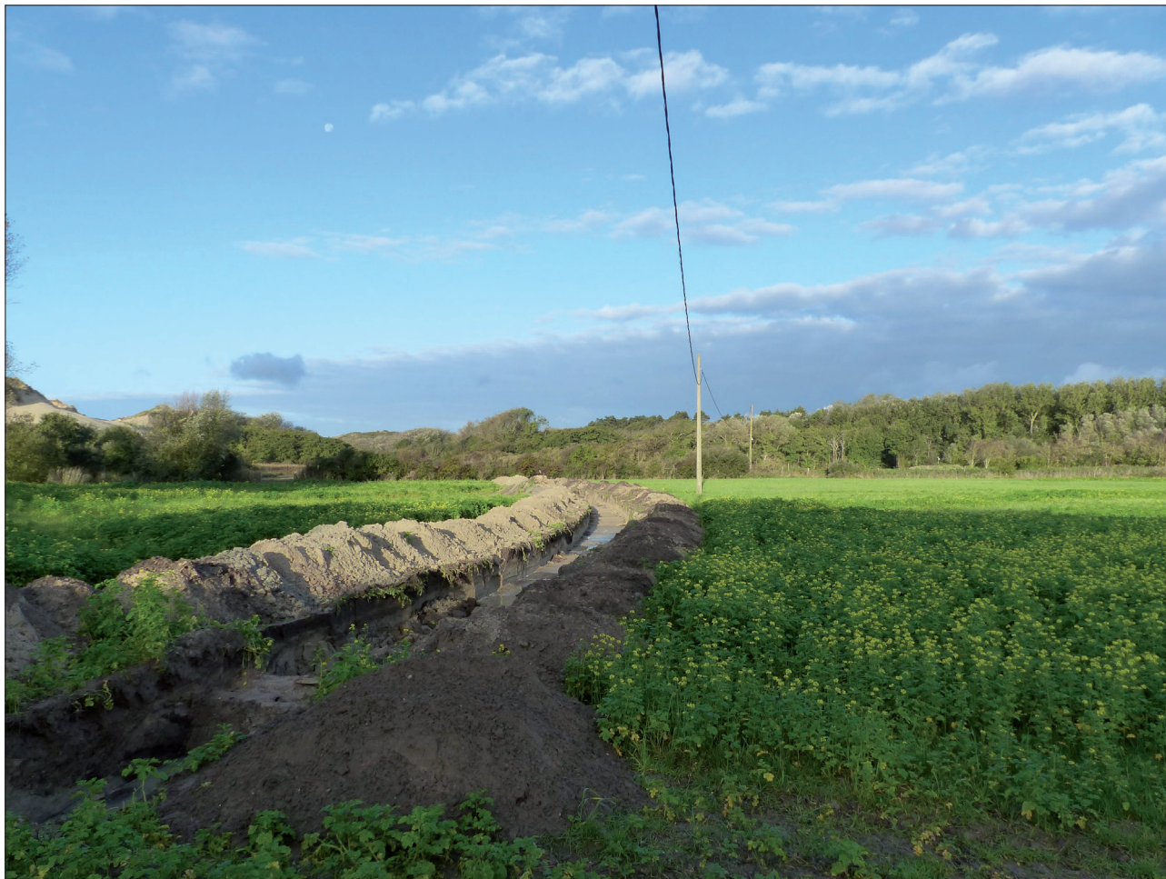
Fig. 31 : Groffliers, digue rétro littorale, Secteur Bois des Sapins, vue générale vers l'ouest de la tranchée 300, cliché O. Dewitte - DA, CD 62.
