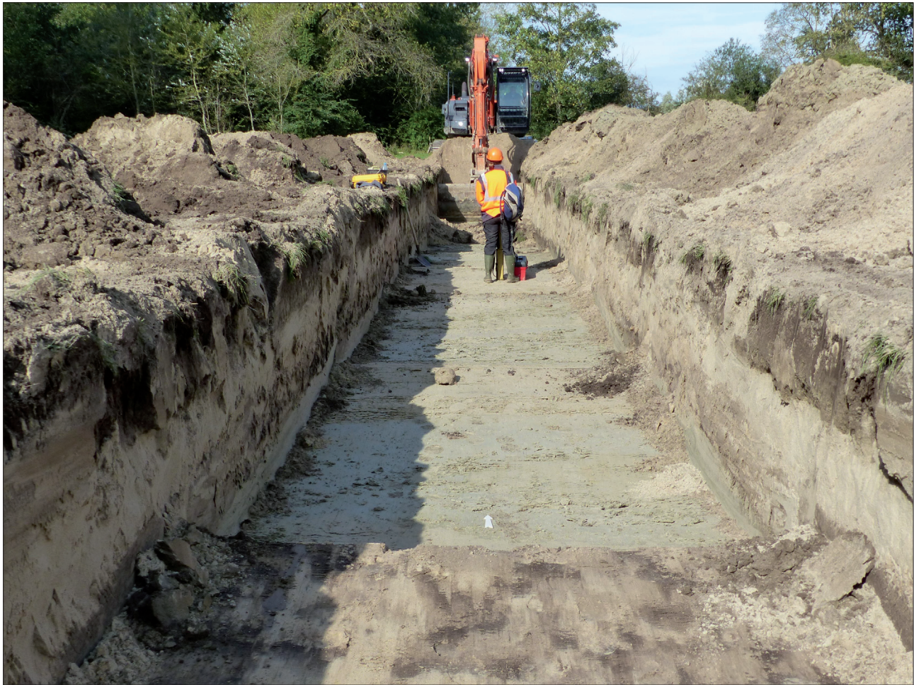
Fig. 15 : Groffliers, digue rétro littorale, Secteur Bois des Sapins, vue générale vers le nord de la tranchée 100, cliché O. Dewitte - DA, CD 62.
