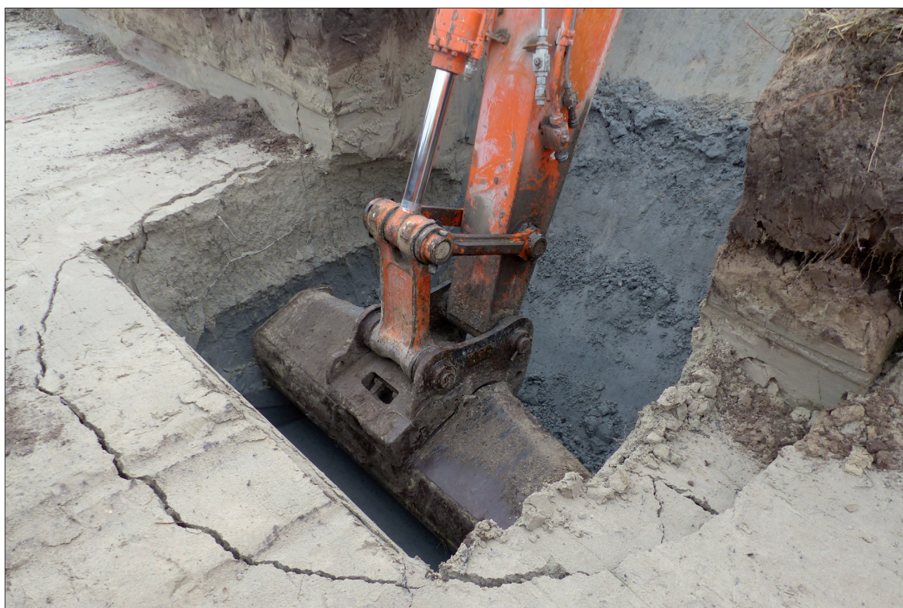
Fig. 43 : Groffliers, digue rétro littorale, Secteur Bois des Sapins, vue du sondage 405 géologique en cours de réalisation, cliché É. Panlouis - DA, CD 62.
