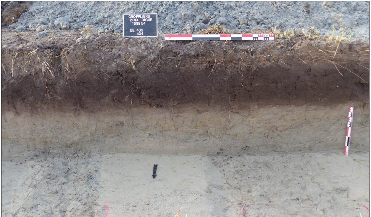
Fig. 47 : Groffliers, digue rétro littorale, Secteur Bois des Sapins, vue en coupe des fossés 403 et 404, cliché É. Panloup - DA, CD 62.
