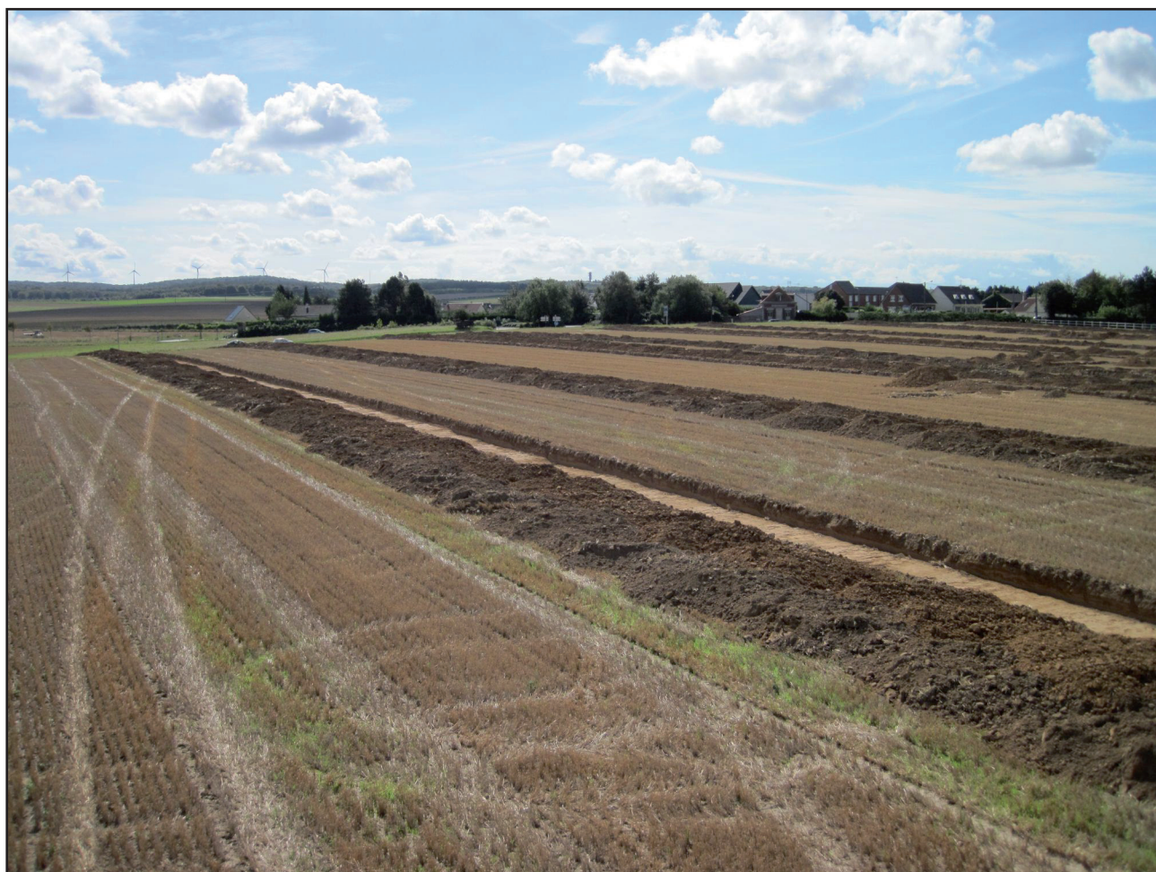
Fig. 9 : Guînes, RD 231, la Rue d'Ardres, vue générale du chantier vers le sud, V. Merkenbreack - CDA-CG62.
