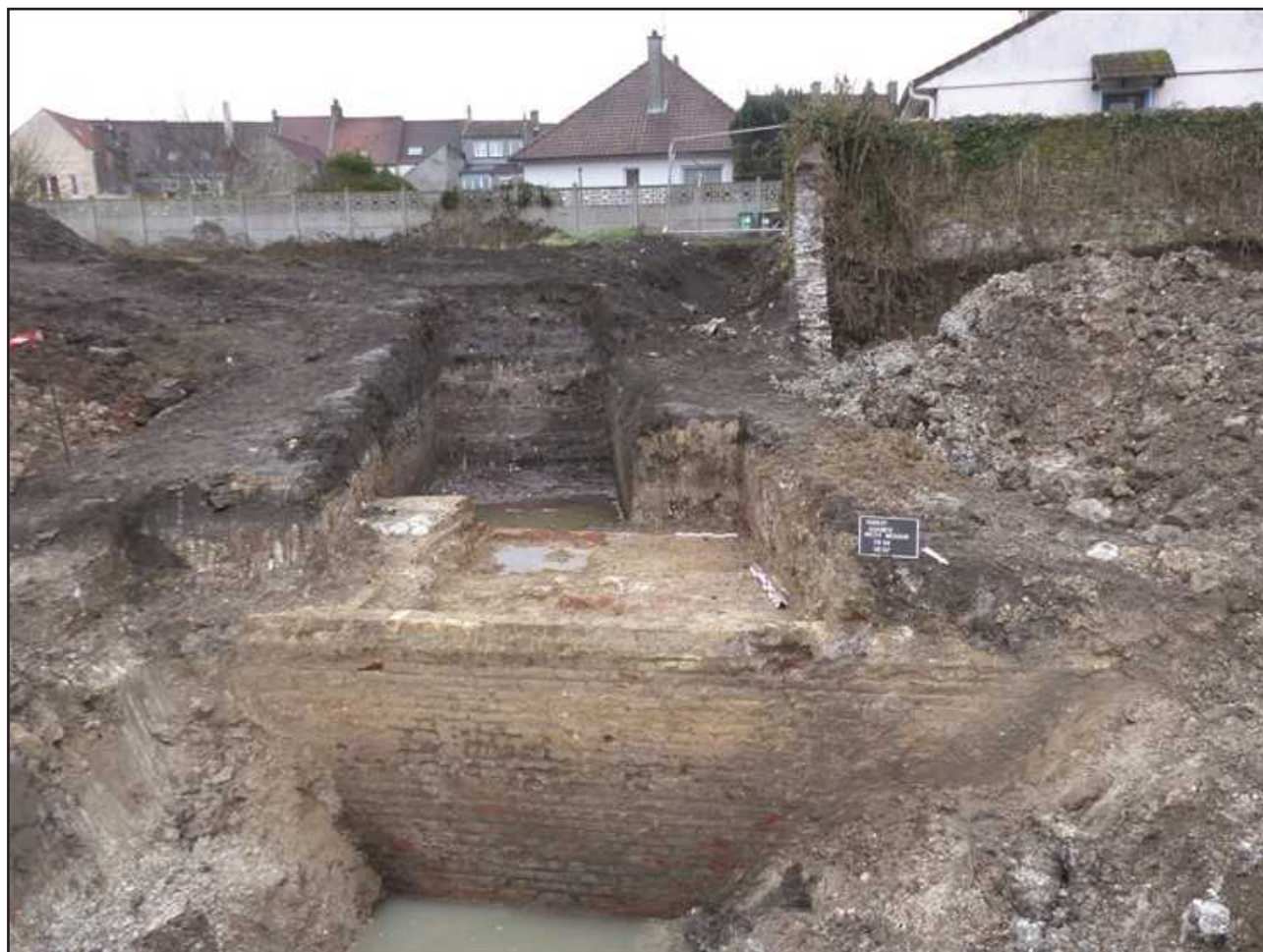
Fig. 47 : Guînes, rue du Petit Moulin, vue du parement extérieur de l'enceinte 57, en arrière-plan les remblais de talus, H. Agostini - DA, CD 62.
