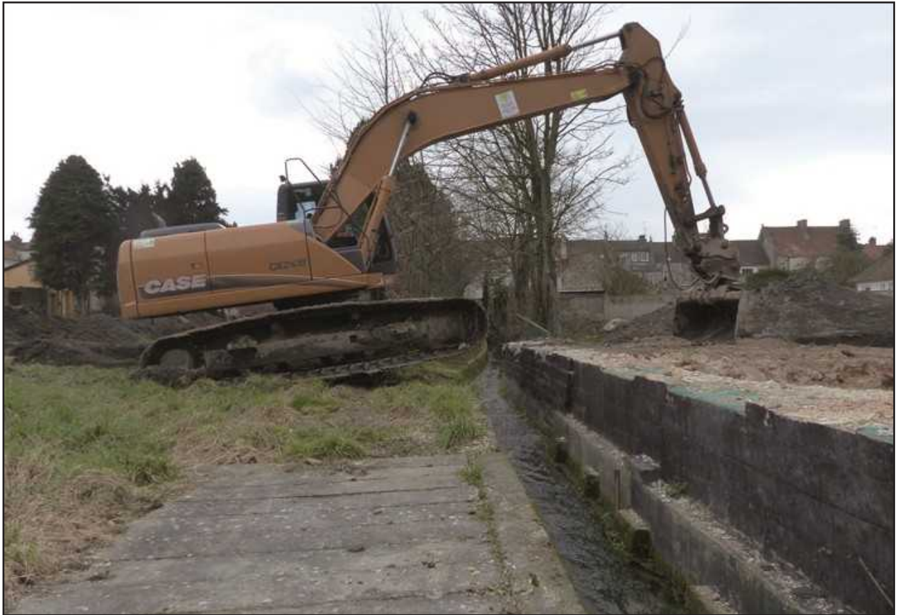
Fig. 26 : Guînes, rue du Petit Moulin, le canal d'amenée d'eau du moulin qui traverse le site, J.-M. Willot - DA, CD 62.
