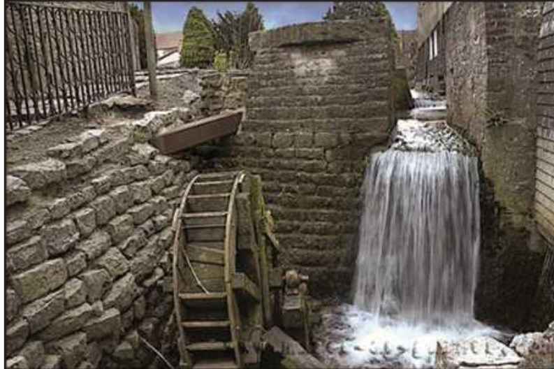
Fig. 68 : Guînes, rue du Petit Moulin, le bassin et la roue à aubes avant son démontage, E. Buy Société historique de Guînes.
