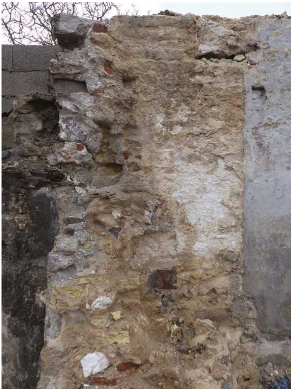
Fig. 67 : Guînes, rue du Petit Moulin, échancré du mur gouttereau oriental du moulin, H. Agostini DA, CD 62 .
