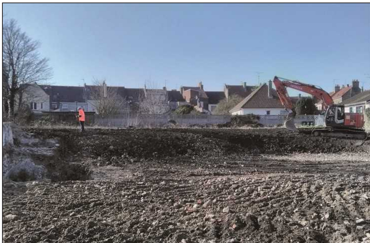
Fig. 25 : Guînes, rue du Petit Moulin, le site après la démolition des bâtiments. À gauche, les celliers du moulin, en arrière-plan, une illustration de la topographie accidentée du terrain, J.-M. Willot - DA, CD 62.
