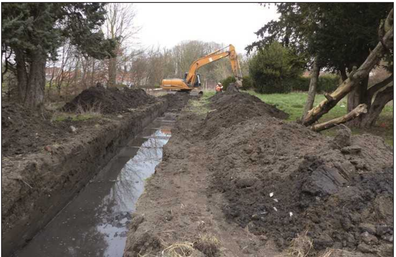
Fig. 27 : Guînes, rue du Petit Moulin, la gestion de l'eau lors des ouvertures des tranchées, J.-M. Willot - DA, CD 62.
