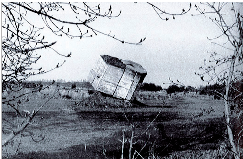
Fig. 47 : Harnes, ZAC de la Motte du Bois, lot 4, vue d'un des aménagements en béton localisé au bois de Florimond, Cliché issu de Coll. 2006 : 60.
