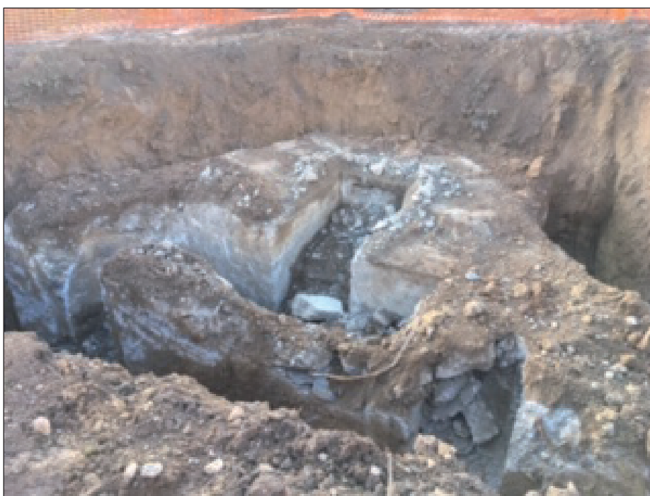
Fig. 9 : Harnes, ZAC de la Motte du Bois, lot 4, Vue du dégagement du «bunker» par la société CARDEM, Cliché E. Leroy-Langelin - DA, CD62 .
