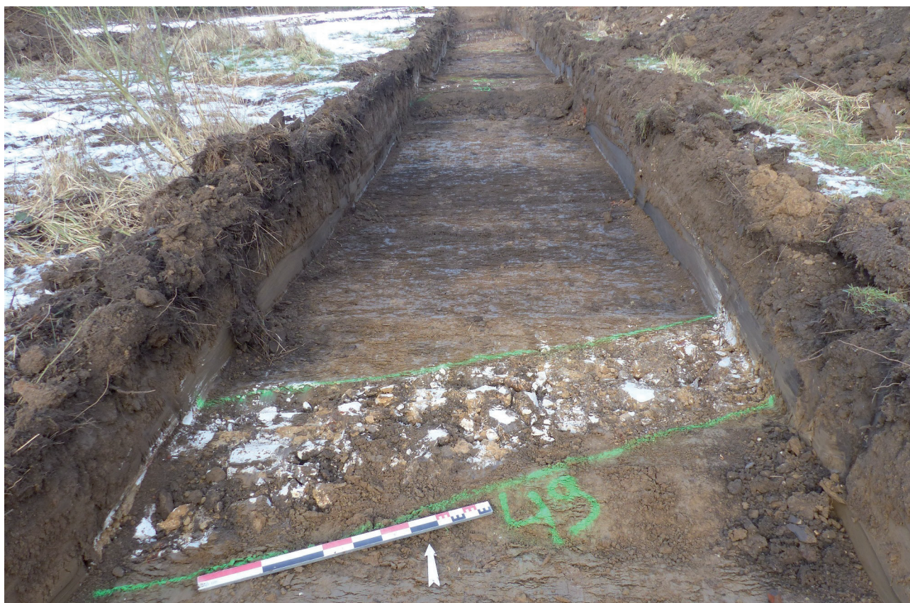
Fig. 18 : vue de fondations 49 et 48 en blocs de craie et mortier, L. Wilket- DA, CD 62.
