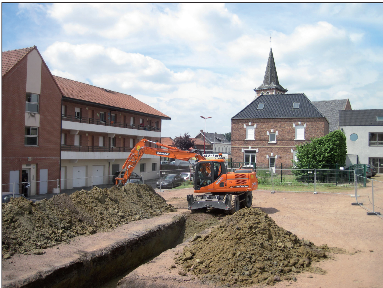
Fig. 11 : Leforest, Centre bourg : Vue vers le nord / ouest de la tranchée UE 01 et des contraintes, cliché C. Costeux - CDA CG62 .
