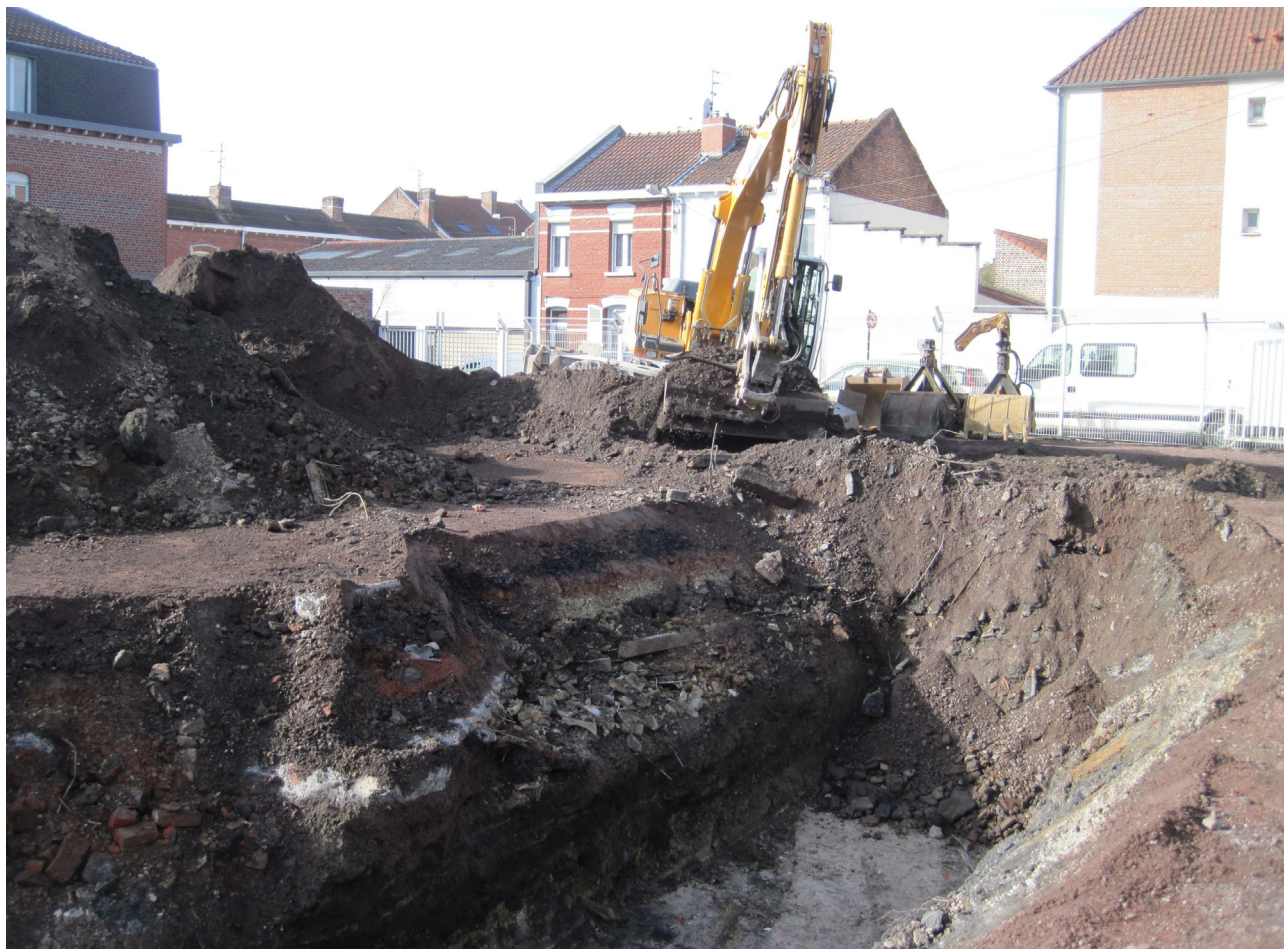
Fig. 9 : Lens, Avenue du 4 Septembre, l'état du sous-sol constitué sur près de 2 m de profondeur de gravats de démolition. J.-M. Willot - DA 62.
