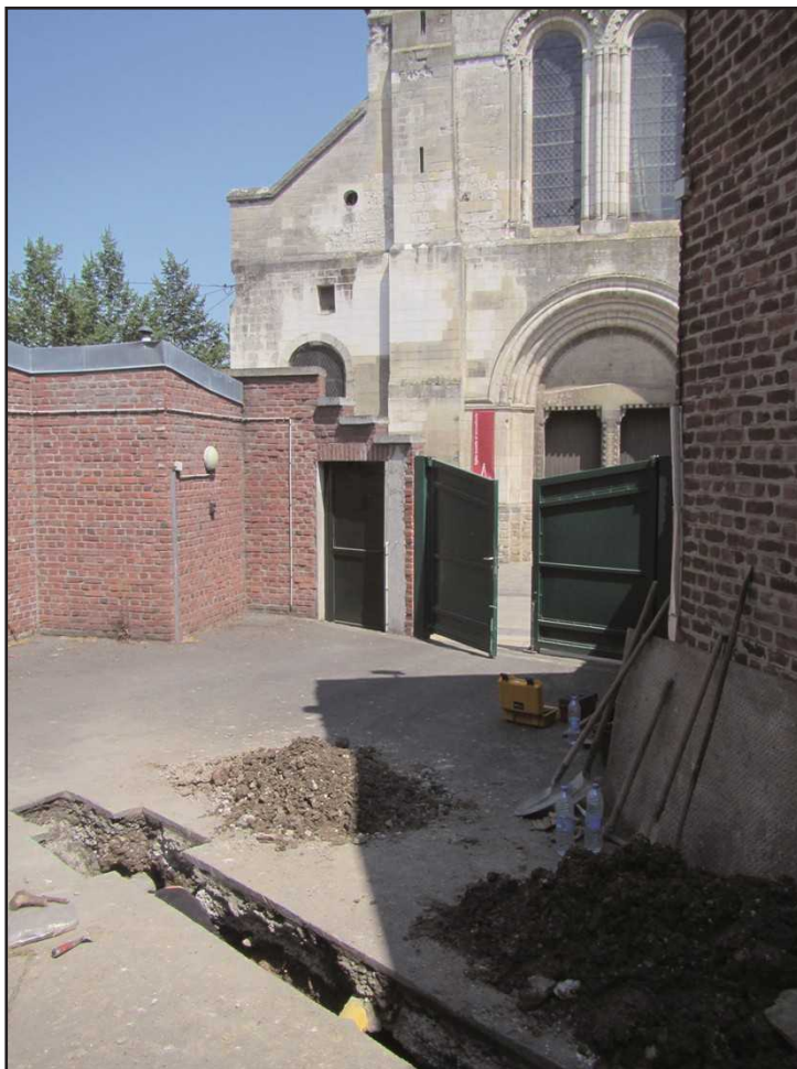
Fig. 16 : Lillers, place de l'Église, tranchée 16 ouverte dans la cour du CCAS, face à la collégiale Saint-Omer, cliché DA, CD 62.
