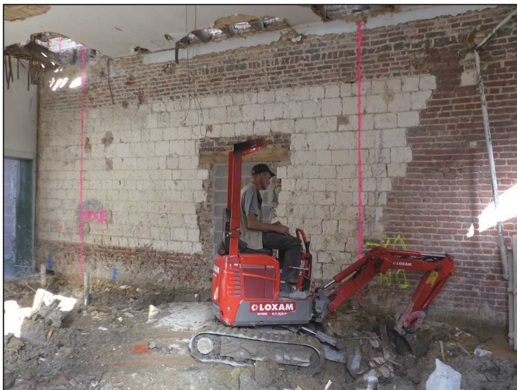
Fig. 17 : Lillers, place de l'Église, creusement de la fosse de fondation 100 pour l'un des futurs contreforts du mur nord-est, cliché DA, CD 62.
