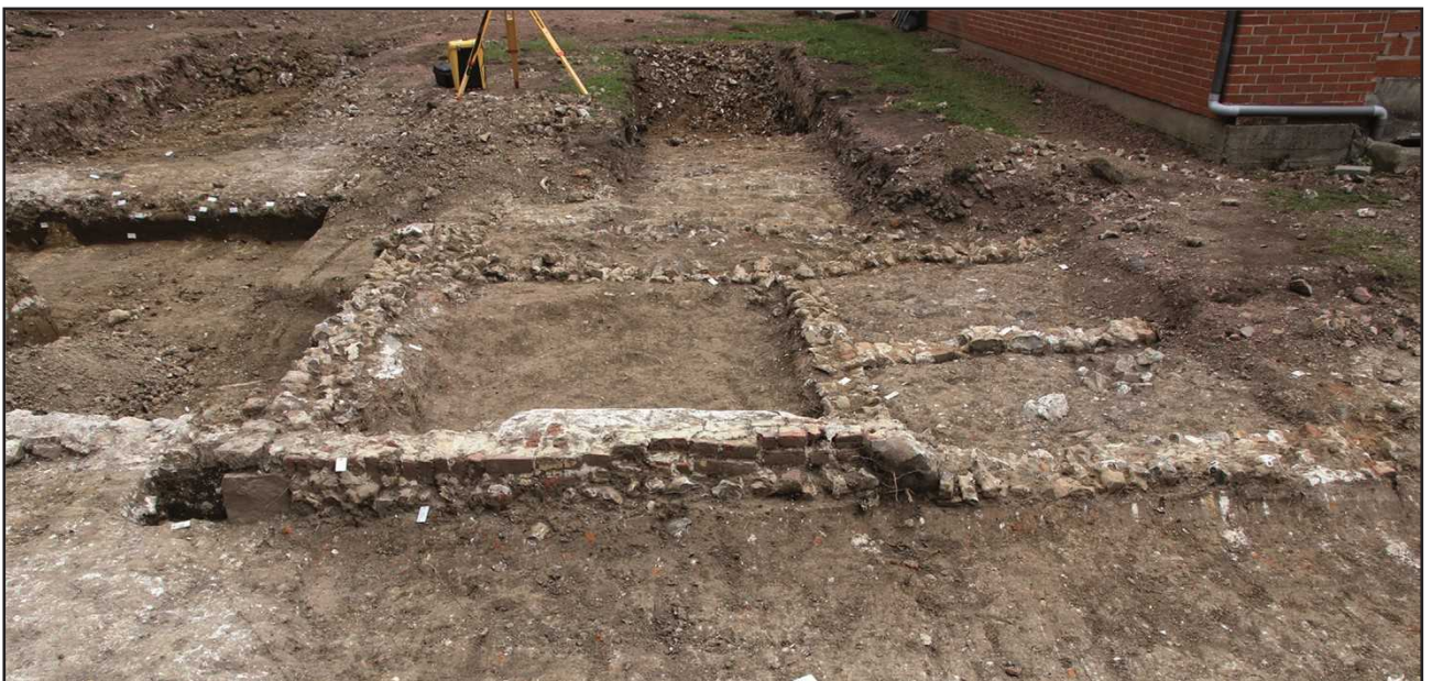
Fig. 60 : Lisbourg, Rue du Prieuré, vue générale du bâtiment 82, cliché D. Delobel - DA 62
