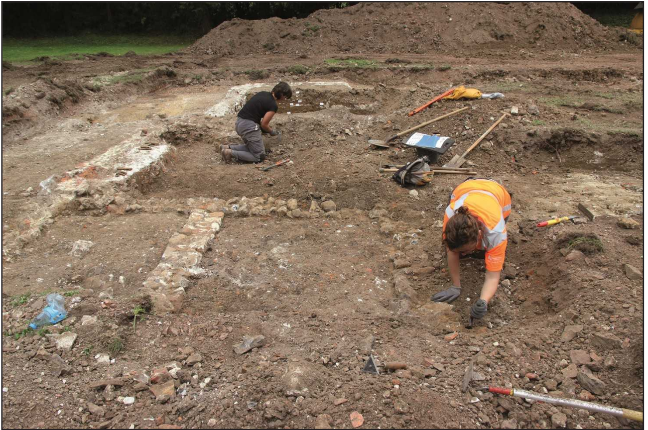
Fig. 59 : Lisbourg, Rue du Prieuré, vue générale du bâtiment 82 en cours de dégagement, cliché D. Delobel - DA 62
