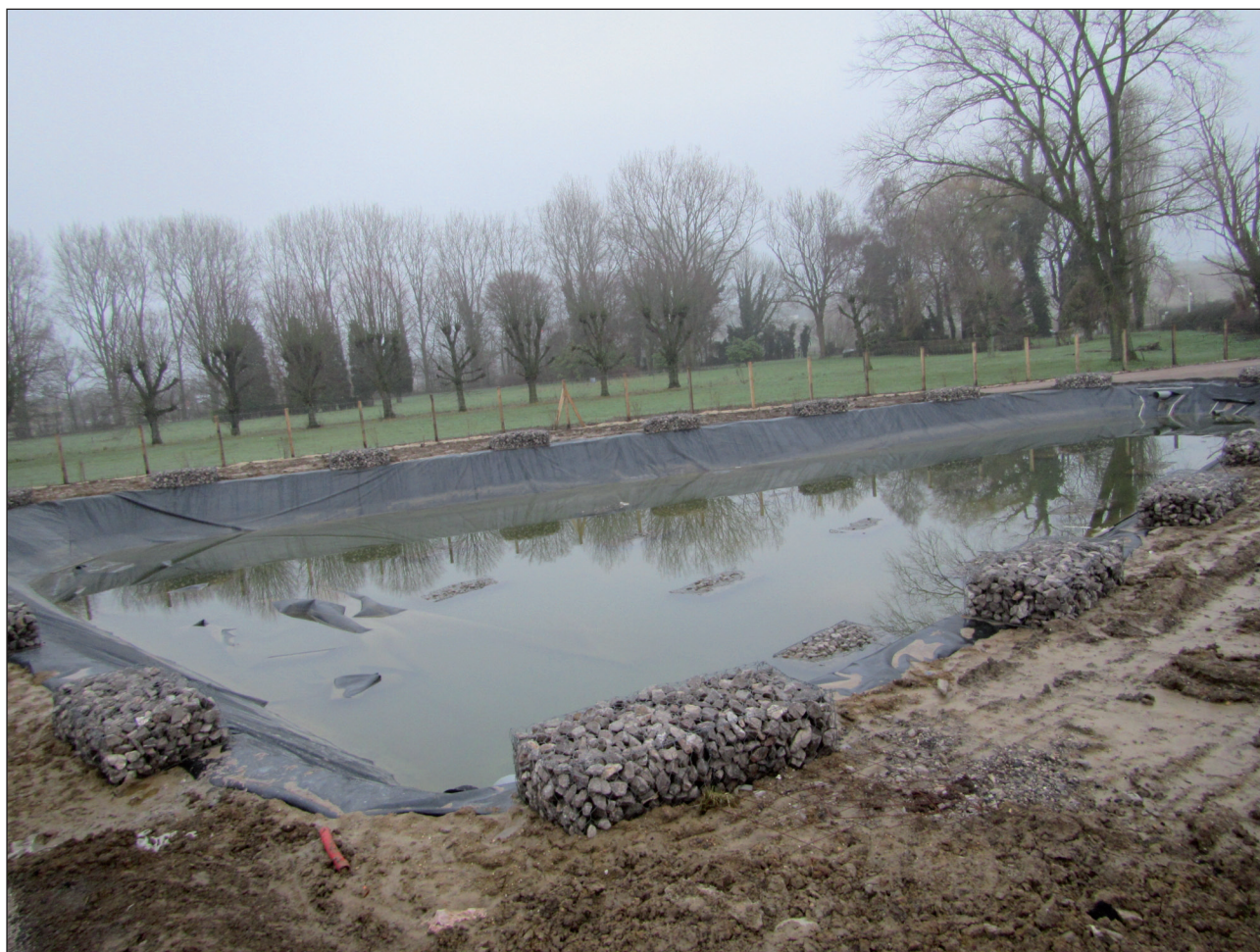
Fig. 6 : Longuenesse, rue Ambroise Paré, Vue du bassin de rétention, situé au sud-est de la zone, Cliché : L. Wilket - DA, CD 62.
