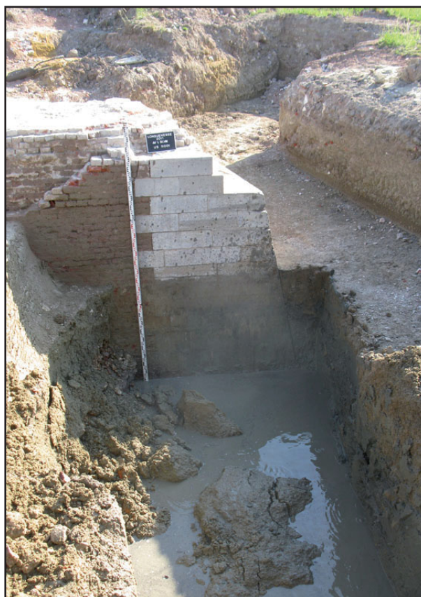
Fig. 24 : Longuenesse, Fort Maillebois, sondage profond à l'aplomb de l'angle du bastion
