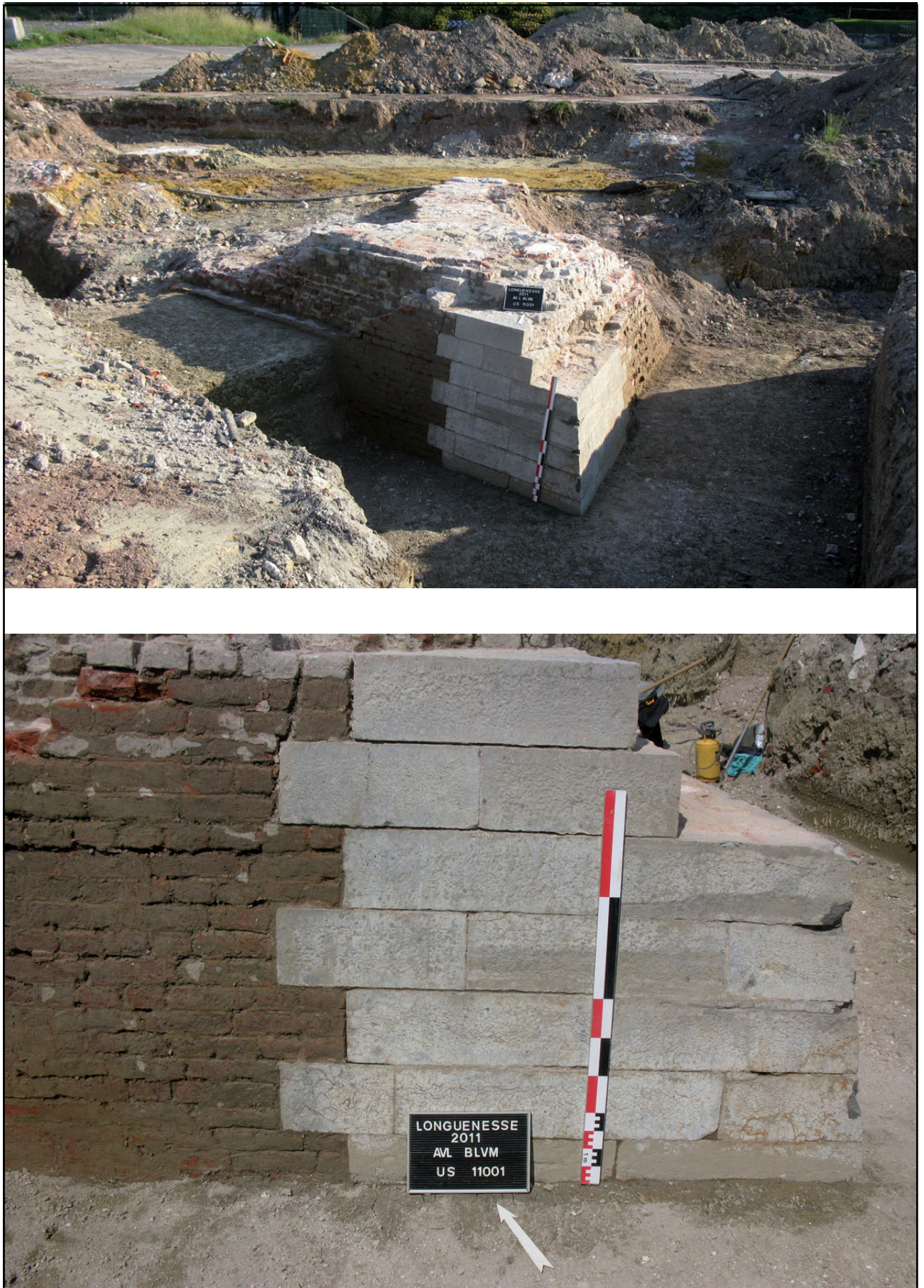
Fig. 25 : Longuenesse, Fort Maillebois, murs d'angle du bastion (UE 11001) et détail du parement externe
