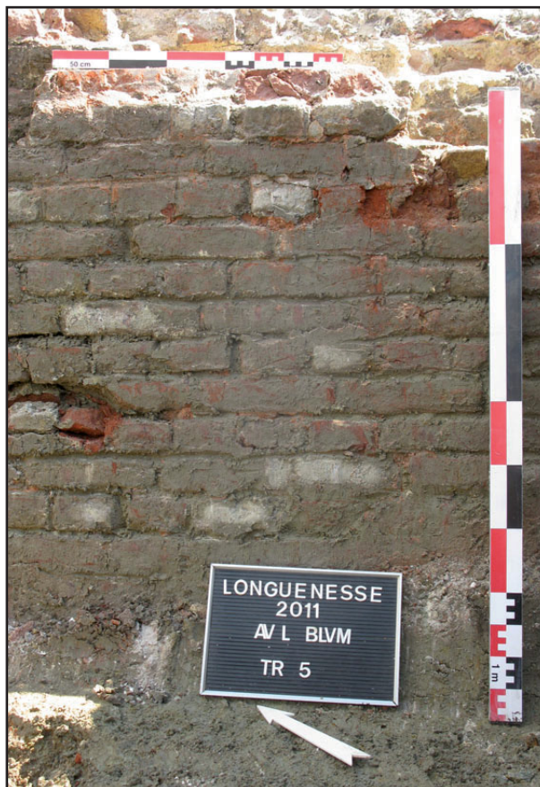
Fig. 20 : Longuenesse, Fort Maillebois, détail du parement externe de briques du mur ouest (UE 5000), tr. 5.
