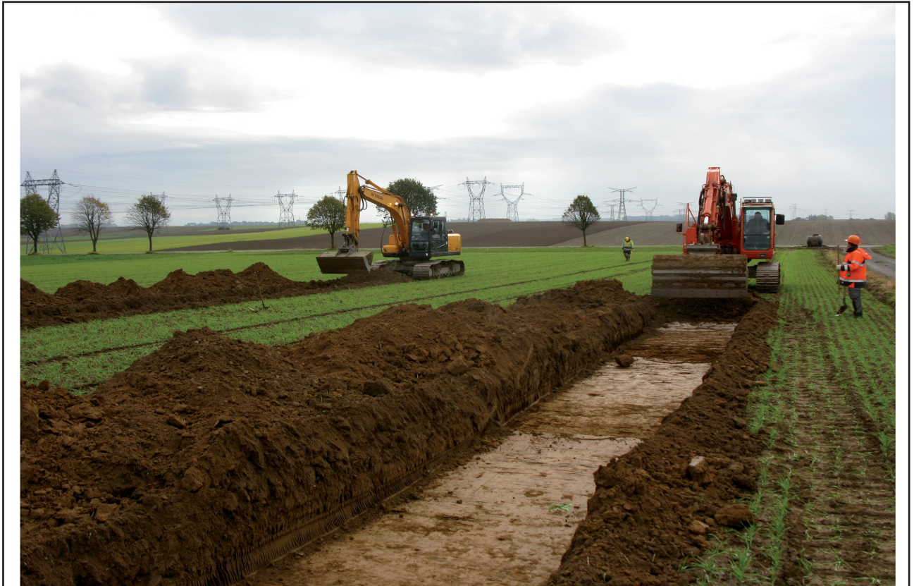
Fig. 9 : Monchy-au-Bois, Le Chevalet, creusement des tranchées avec deux pelles
