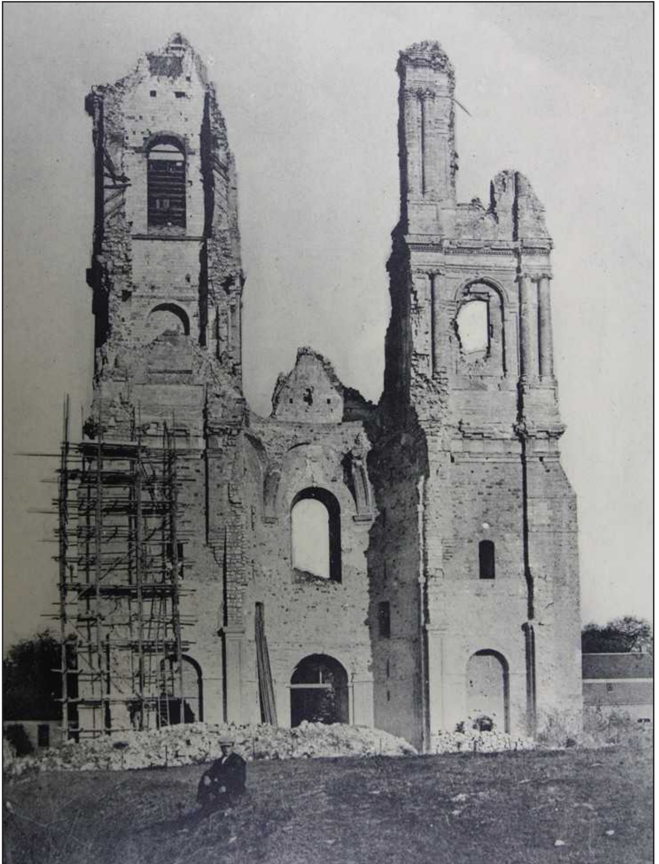
Fig. 23 : les deux tours en cours de restauration après les dégâts de la Première Guerre Mondiale (Archives départementales du Pas-de-Calais, sous-série 3 fi 304-03).
