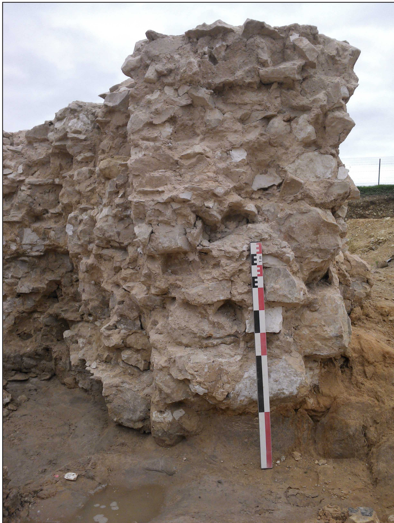
Fig. 42 : Mont-Saint-Eloi, traces d'un creusement dans le substrat sous la maçonnerie romane - cliché J.-M. Willot - CDA CG62.
