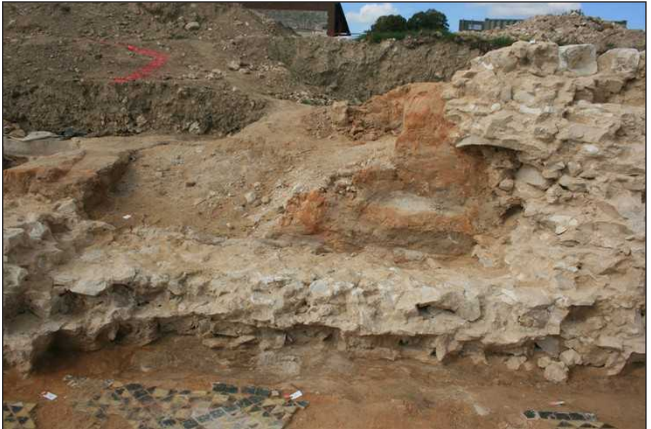
Fig. 67 : Mont-Saint-Eloi, le mur nord-ouest UE 2467 et sa tranchée de fondation creusée dans le substrat sableux - cliché J.-M. Willot - CDA CG62.
