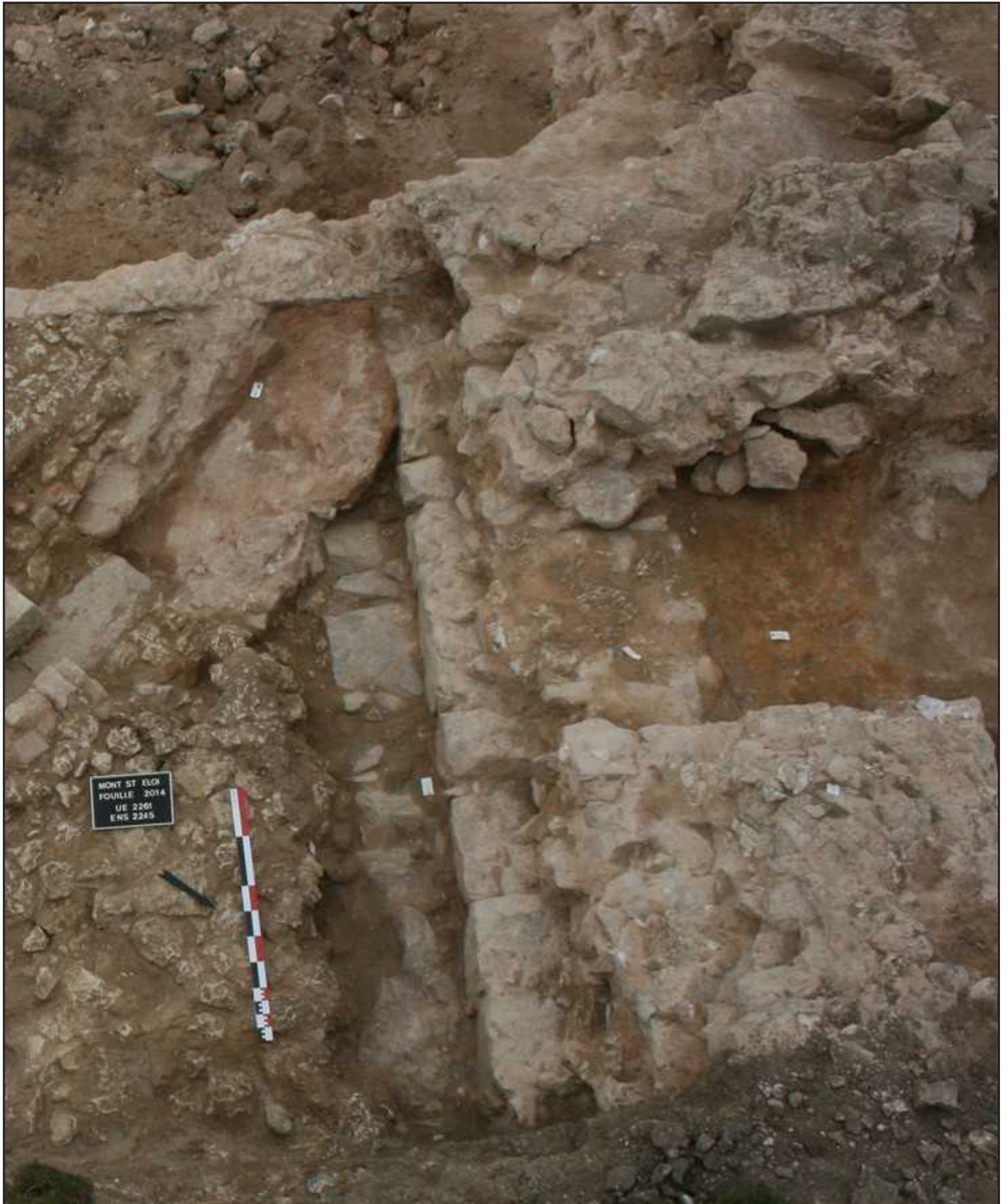
Fig. 86 : Mont-Saint-Eloi, la maçonnerie UE 2199 de la deuxième chapelle avec la reprise moderne UE 2137 - cliché J.-M. Willot - CDA CG62.
