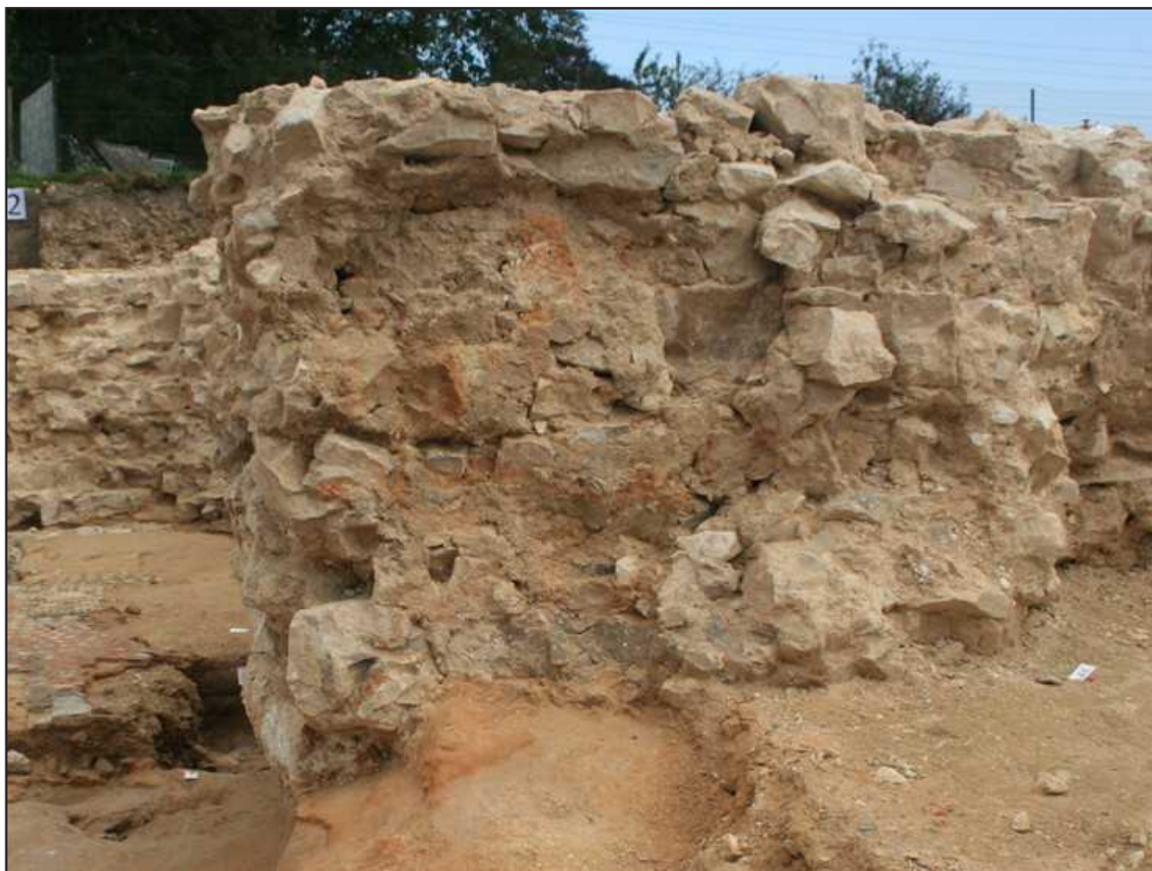
Fig. 56 : Mont-Saint-Eloi, les traces de l'accroche du massif d'angle UE 2182 sur une maçonnerie plus ancienne - cliché J.-M. Willot - CDA CG62.
