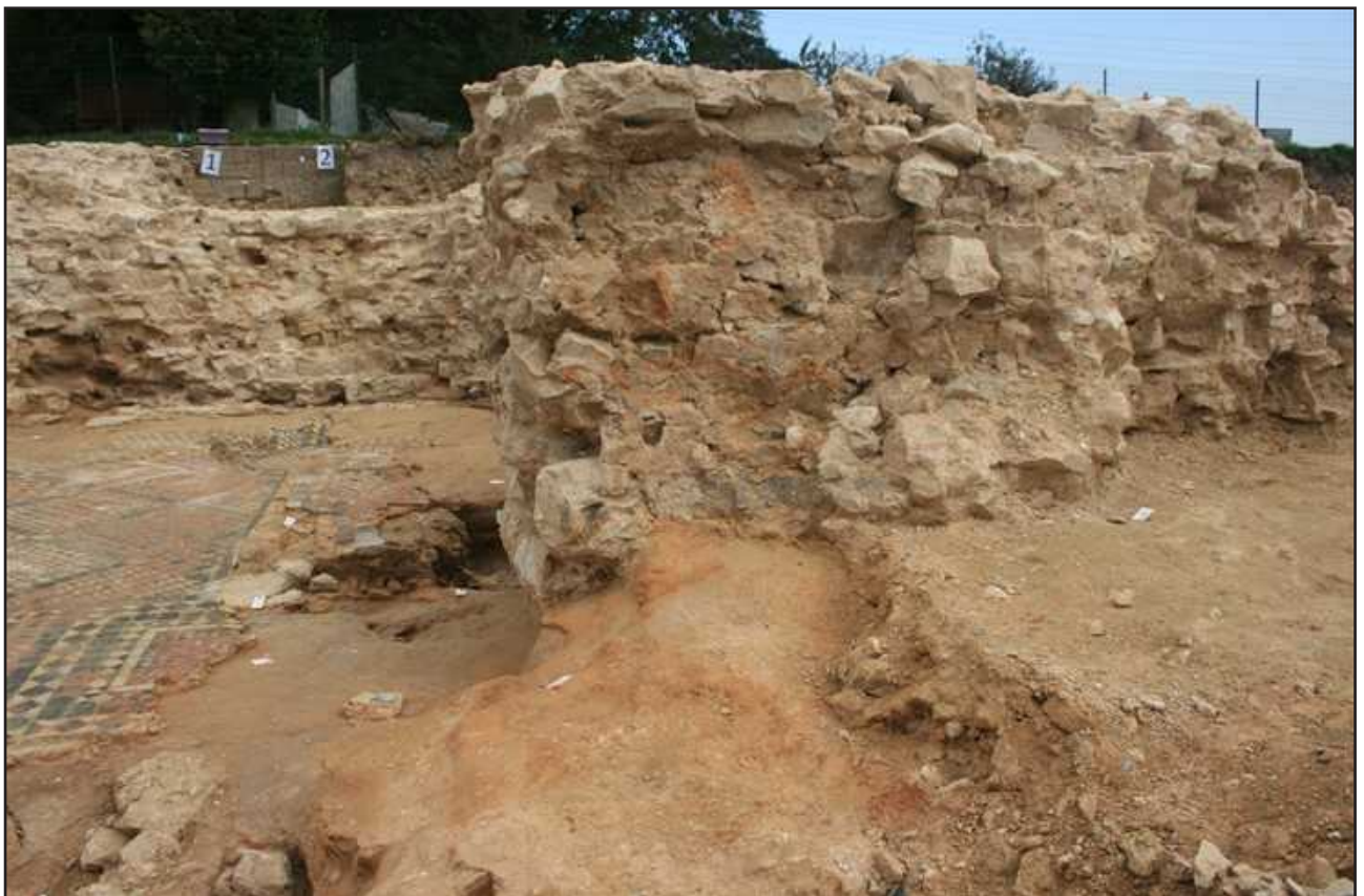
Fig. 34 : Mont-Saint-Eloi, la maçonnerie UE 2478. On y voit un placage de mortier signalant une accroche sur une ancienne structure - cliché J.-M. Willot - CDA CG62.
