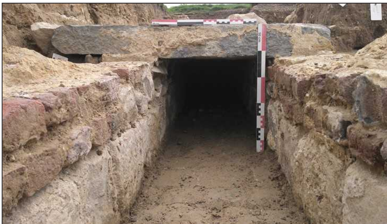
Fig. 107 : Mont-Saint-Eloi, vue de la canalisation UE 2245 - cliché J.-M. Willot - CDA CG62.
