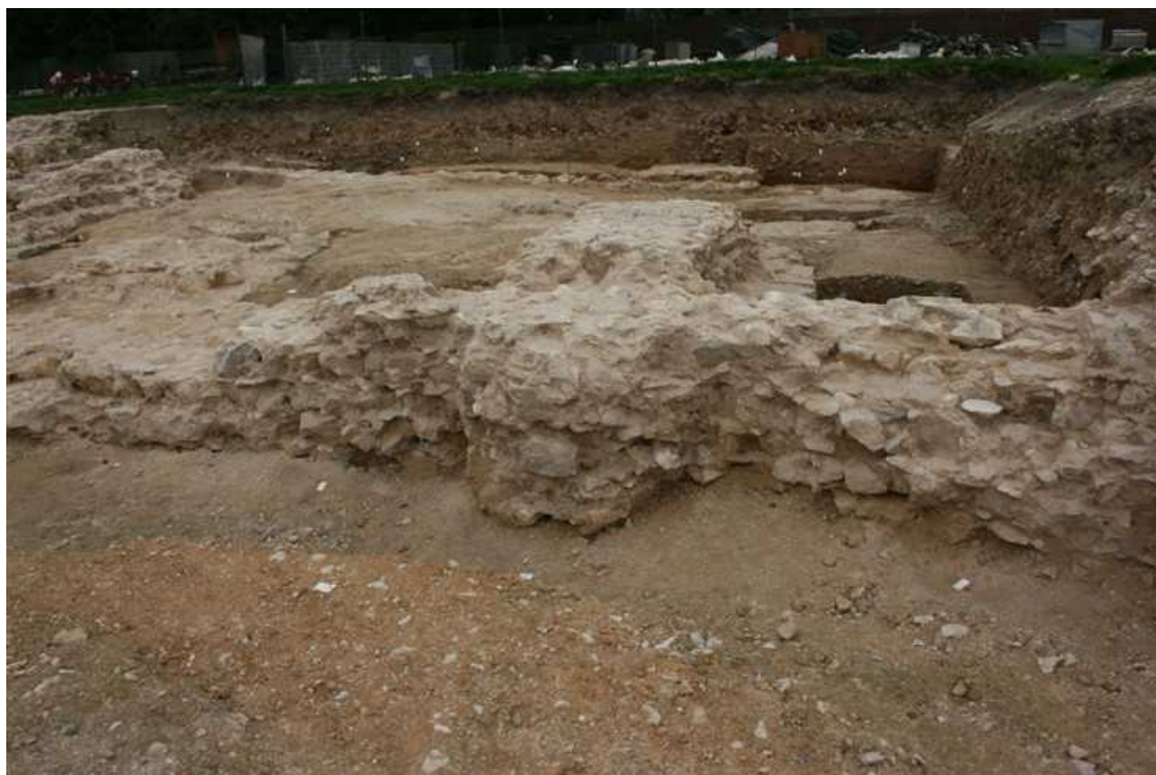
Fig. 52 : Mont-Saint-Eloi, vue du fourrage de la fondation de choeur UE 2428 - cliché J.-M. Willot - CDA CG62.
