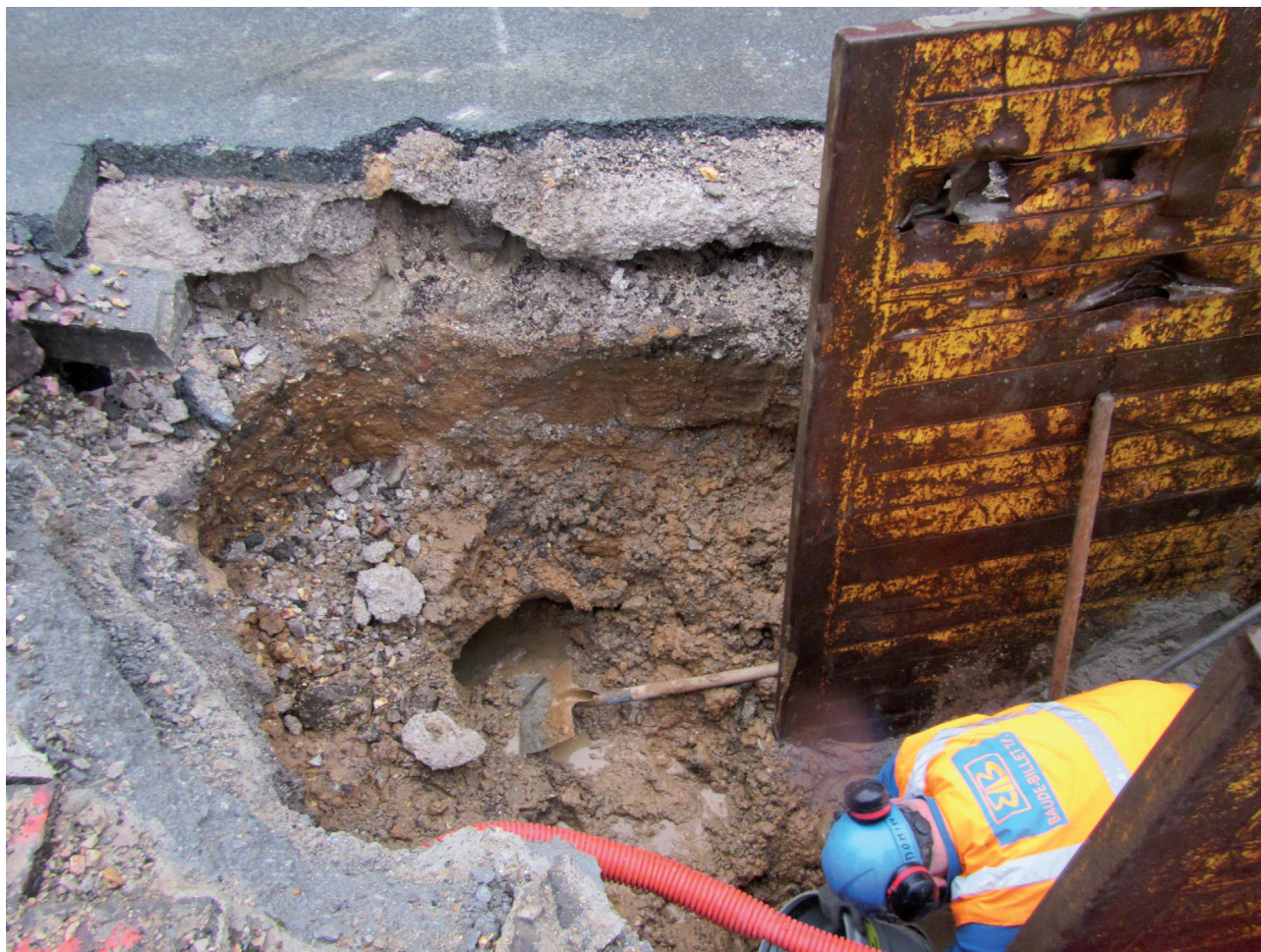
Fig. 13 : Montreuil-sur-Mer, Place du Général de Gaulle, Vue de la tranchée de remplacement de l'assainissement, V. Merkenbreack - DA62.
