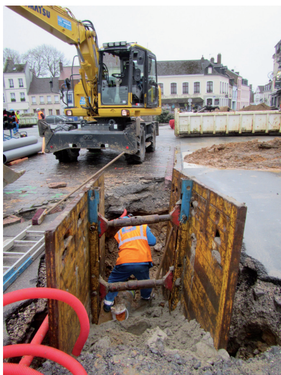
Fig. 14 : Montreuil-sur-Mer, Place du Général de Gaulle, Vue de la tranchée de remplacement de l'assainissement, V. Merkenbreack - DA62.
