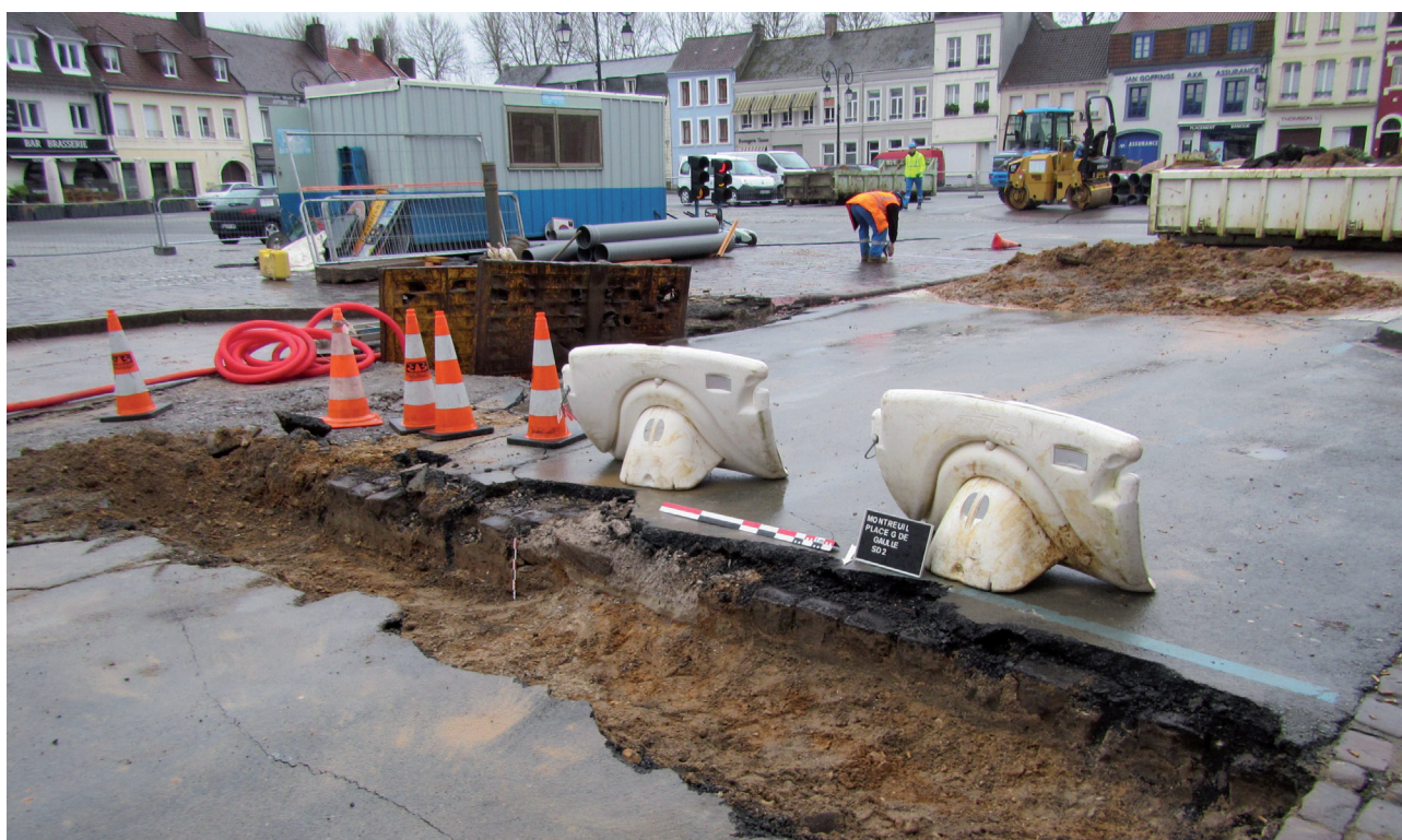
Fig. 10 : Montreuil-sur-Mer, Place du Général de Gaulle, Vue du sondage 2, V. Merkenbreack - DA62.
