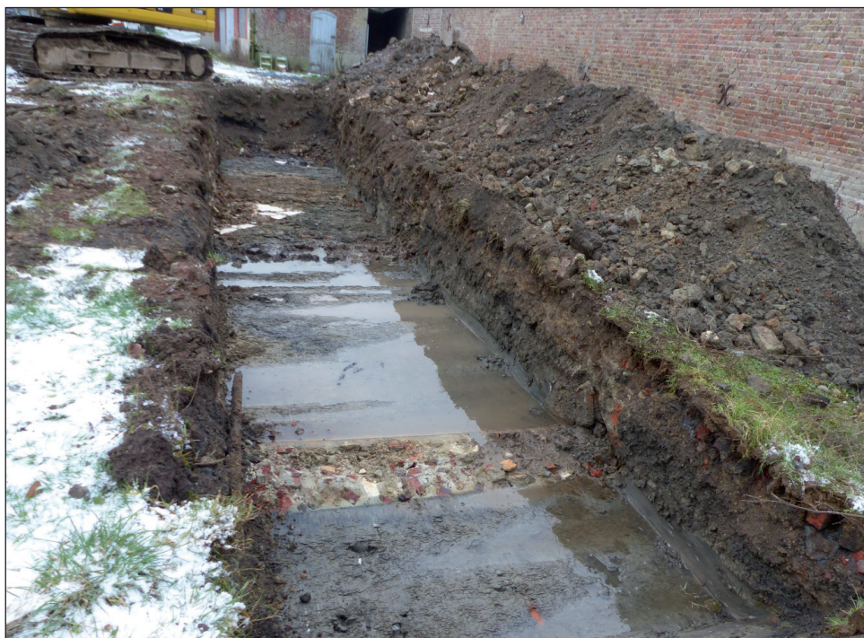
Fig. 12 : Rollancourt, 4 rue du Moulin, vue de la tranchée 5. Cliché : E. Leroy-Langelin - DA, CD 62.
