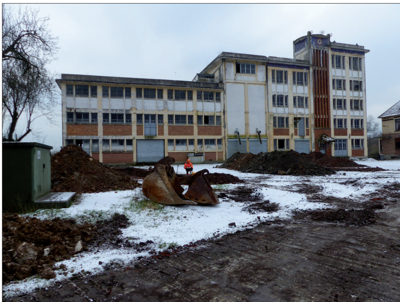
Fig. 9 : Rollancourt, 4 rue du Moulin, vue générale du terrain, de l'armoire électrique sur la gauche et du bâtiment à détruire sur la droite. Cliché : E. Leroy-Langelin - DA, CD 62.
