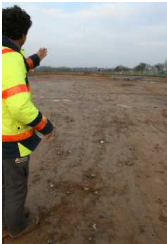
Fig. 140 : Vue générale des ornières et du cailloutis piégé dans ces dernières, cliché L. Malutta - DA, CD 62.
