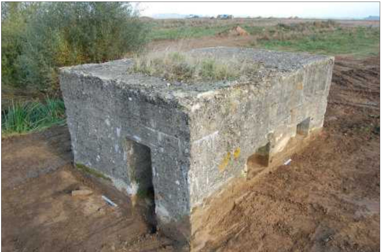
Fig. 377 : Vue générale du pillbox après nettoyage des abords, cliché V. Merkenbreack .
