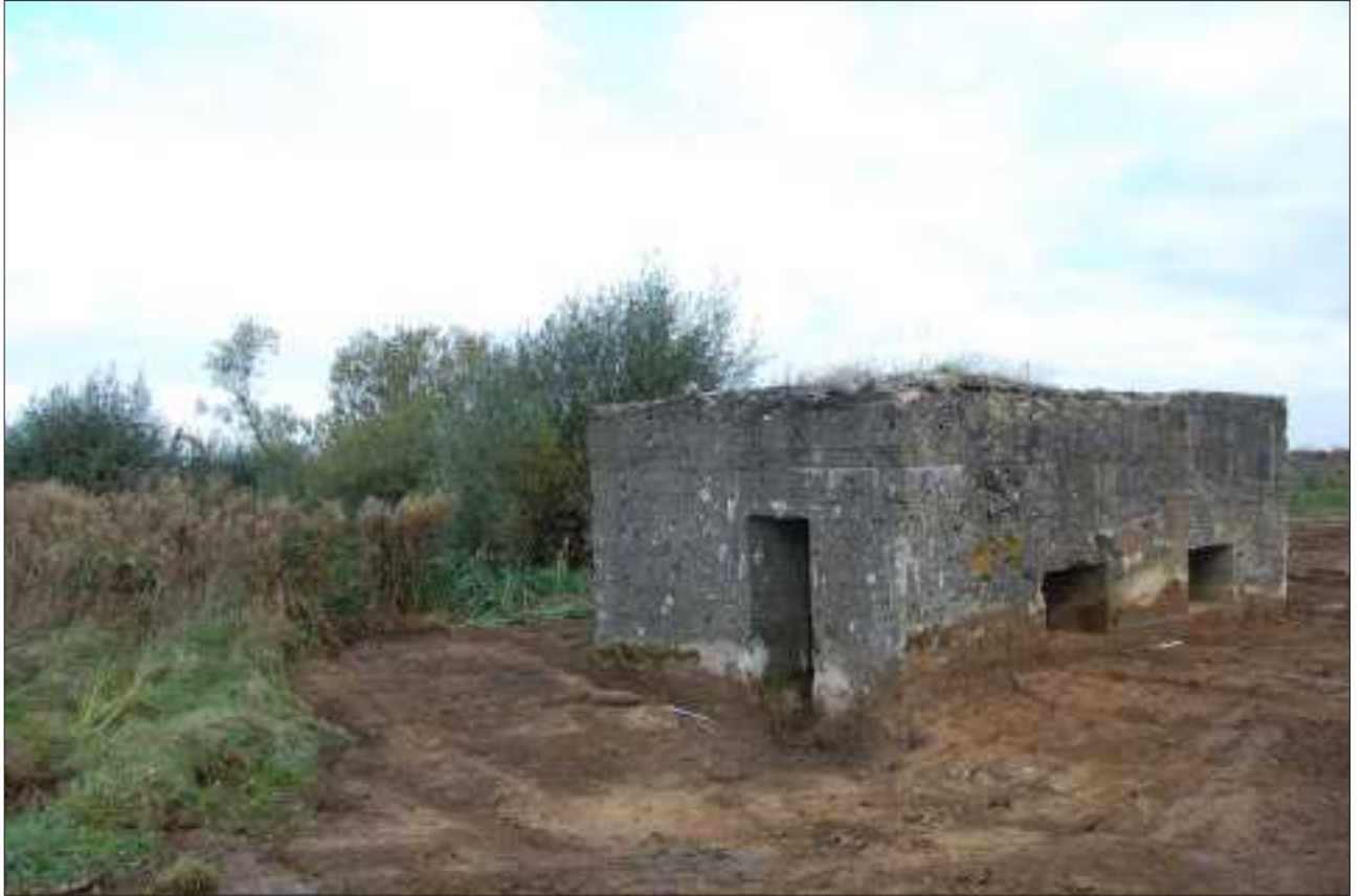
Fig. 376 : Vue générale du pillbox après nettoyage des abords, cliché V. Merkenbreack .
