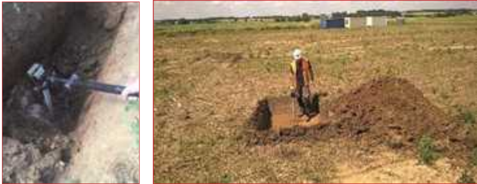
Contrôle QA/QC en fond de fouille avec mise en œuvre du MAGNEX120
