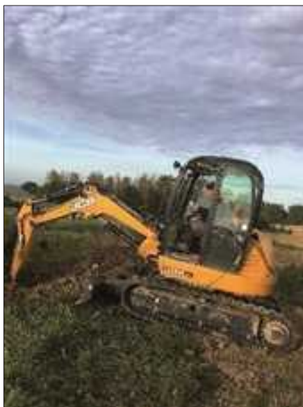
Mise en œuvre de la pelle de 6t
