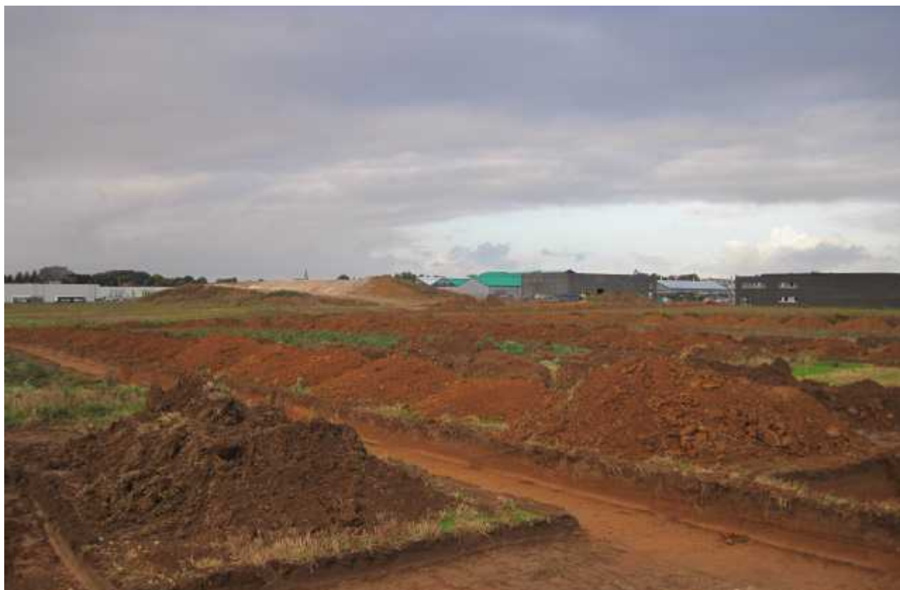
Fig. 11 : Beaurains, Chantier de la Pigache, vue sud-ouest des tranchées avec au premier plan la tranchée UE 08.
